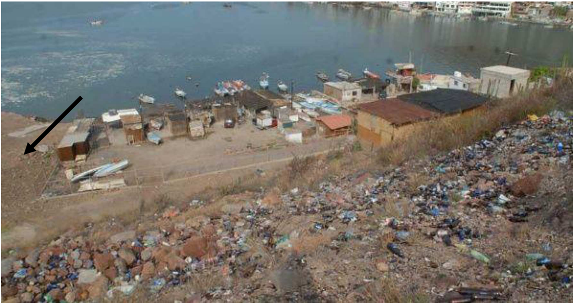
Figura 2.6 en la porción este del predio, puede apreciarse el escenario original, previo a las obras de la cooperativa, ya que aún existen las obras de origen de este sitio, las cuales consisten en rellenos con materiales pétreos producto de la misma excavación del cerro para dar paso a las salida de agua de la CFE.
