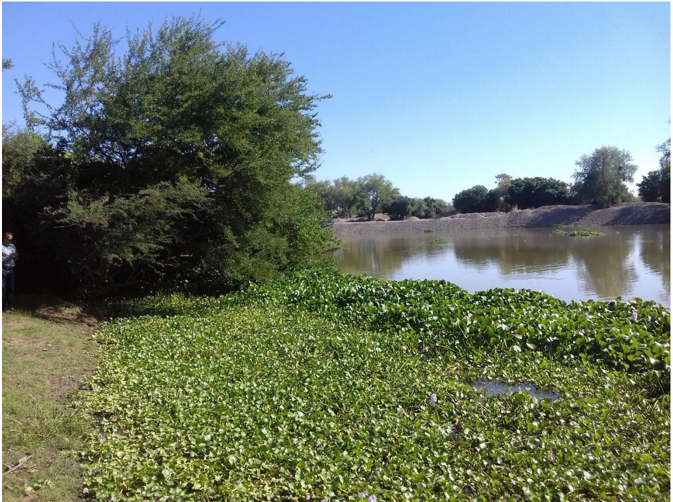
Imagen VIII.5. Evidencia como quedo la margen izquierda del rio Fuerte una vez que se realizó el desazolve y la extracción de materiales pétreos, se puede observar como quedaron en pie los árboles que no fue necesario retirar, ese sistema se pretende aplicar en este proyecto.
