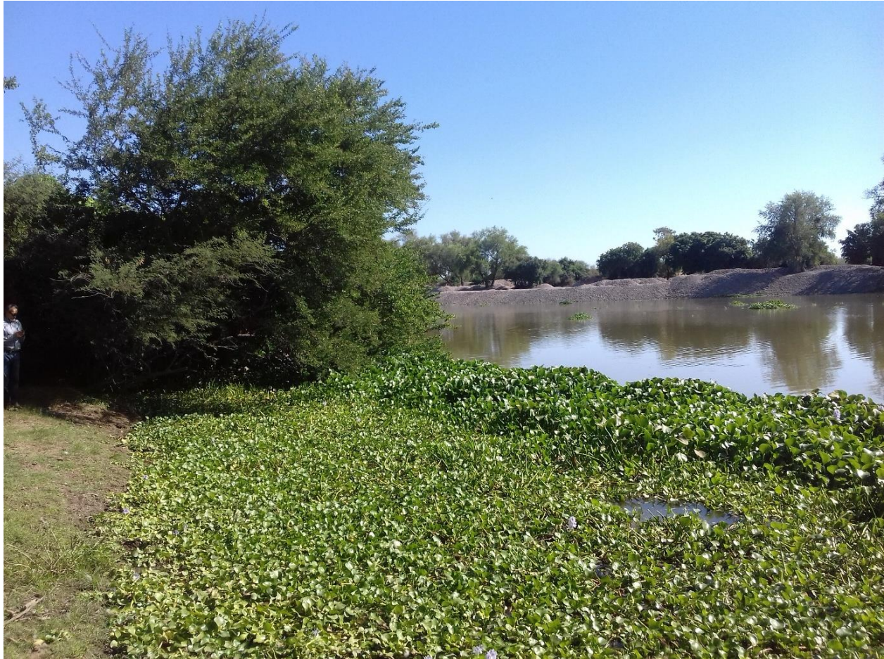
Imagen VIII.1. Parte de la margen derecha del Rio Fuerte y se observa ya desazolvado la parte del otro margen del rio.
