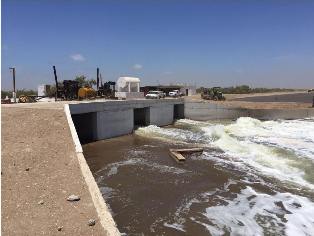
**Figura II.7.** Cárcamo de bombeo, reservorio e instalaciones de la granja El Macapule
