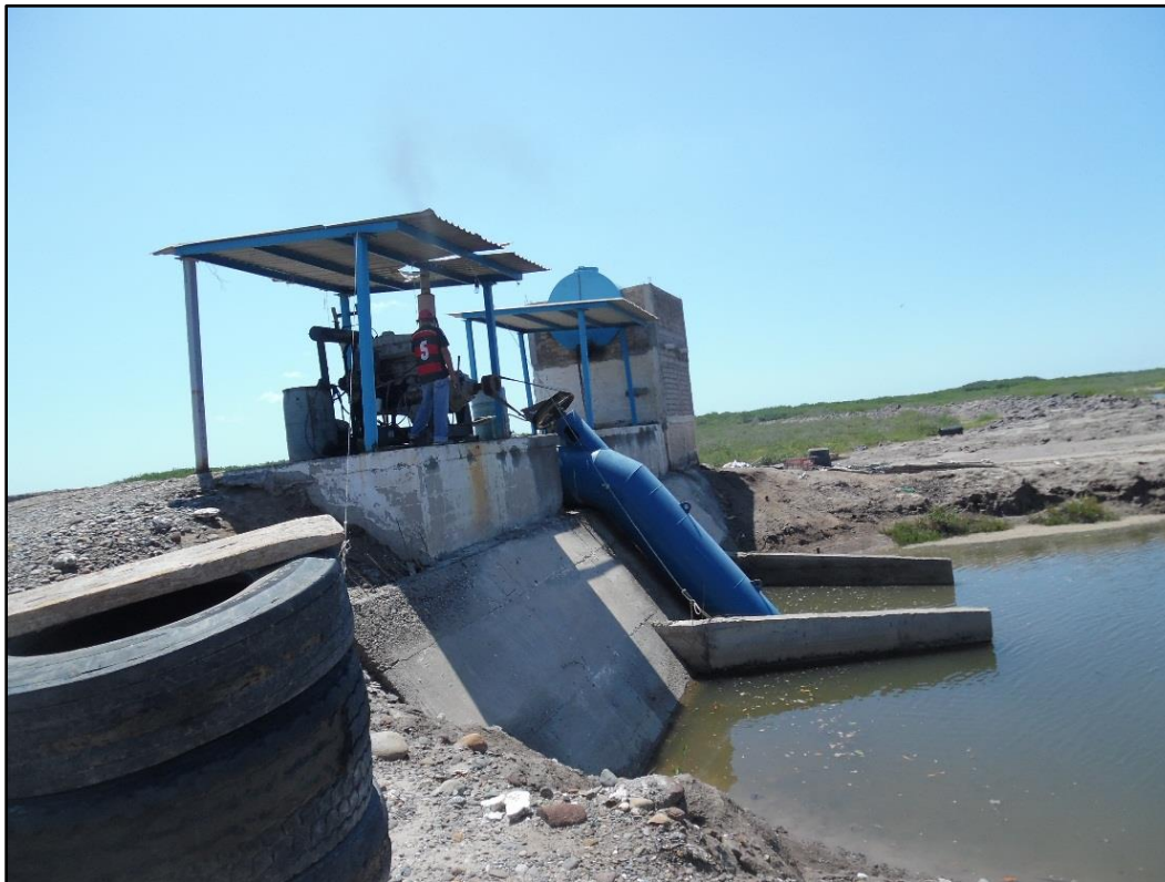
Figura II.3.- Imagen del cárcamo de bombeo de Grupo Acuacultores Angulo S.A. de C.V.
