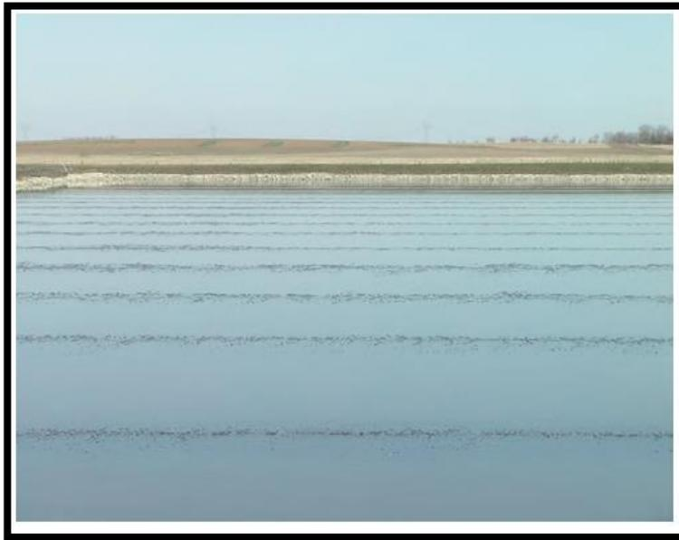
Figura VI.1. Disposición de aireación por del ADS en estructuras acuáticas para el tratamiento de efluentes
