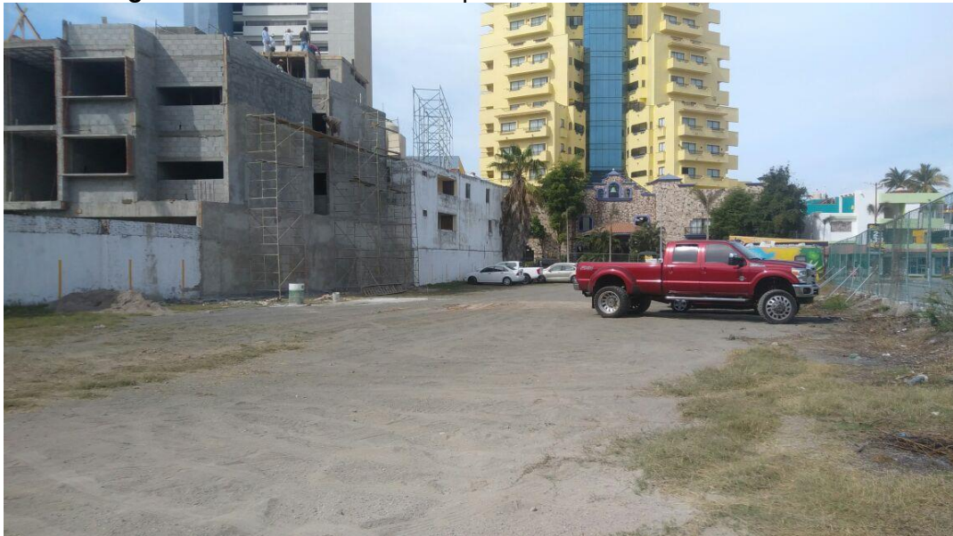
Fotografía IV.2. Vista interior del predio tomada de la playa de Sur a Norte.
