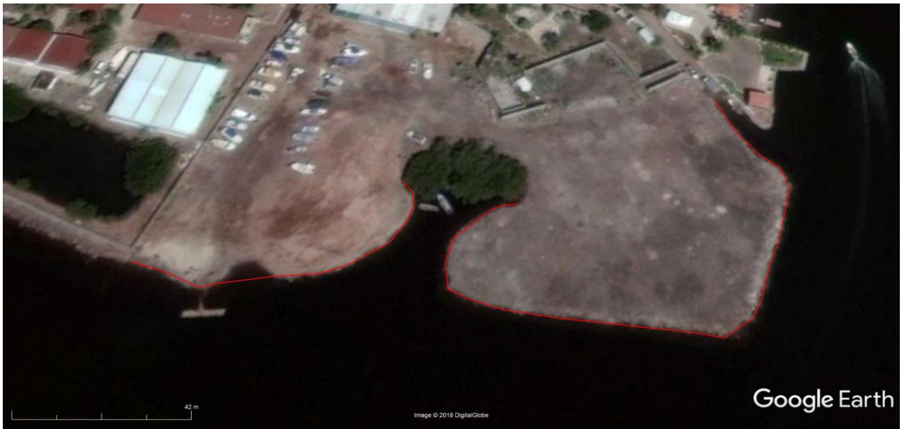
Figura 23. Muro de contención proyectado para la protección de las áreas de rellenos ya realizadas y las proyectadas para concluir la etapa de relleno.
