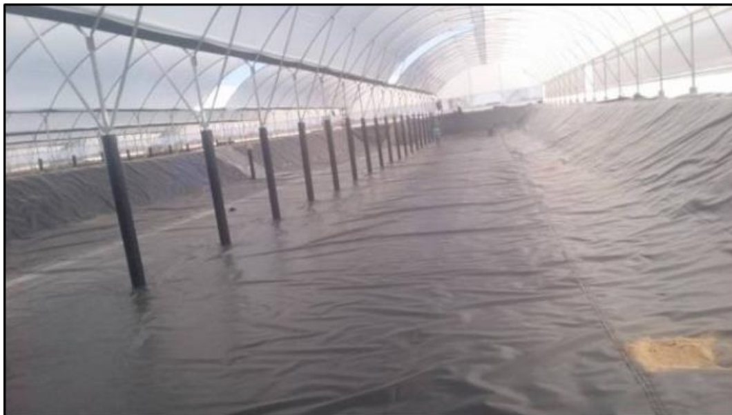
Figura 10. Ejemplo de estanques cubiertos con geomembrana de alta densidad.
