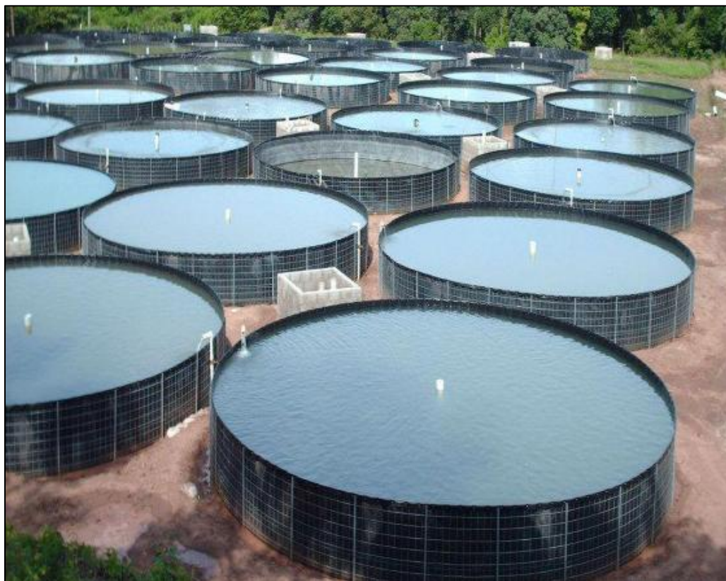
Figura 9. Ejemplo de Estanques Circulares Fabricados con Geomembrana.
