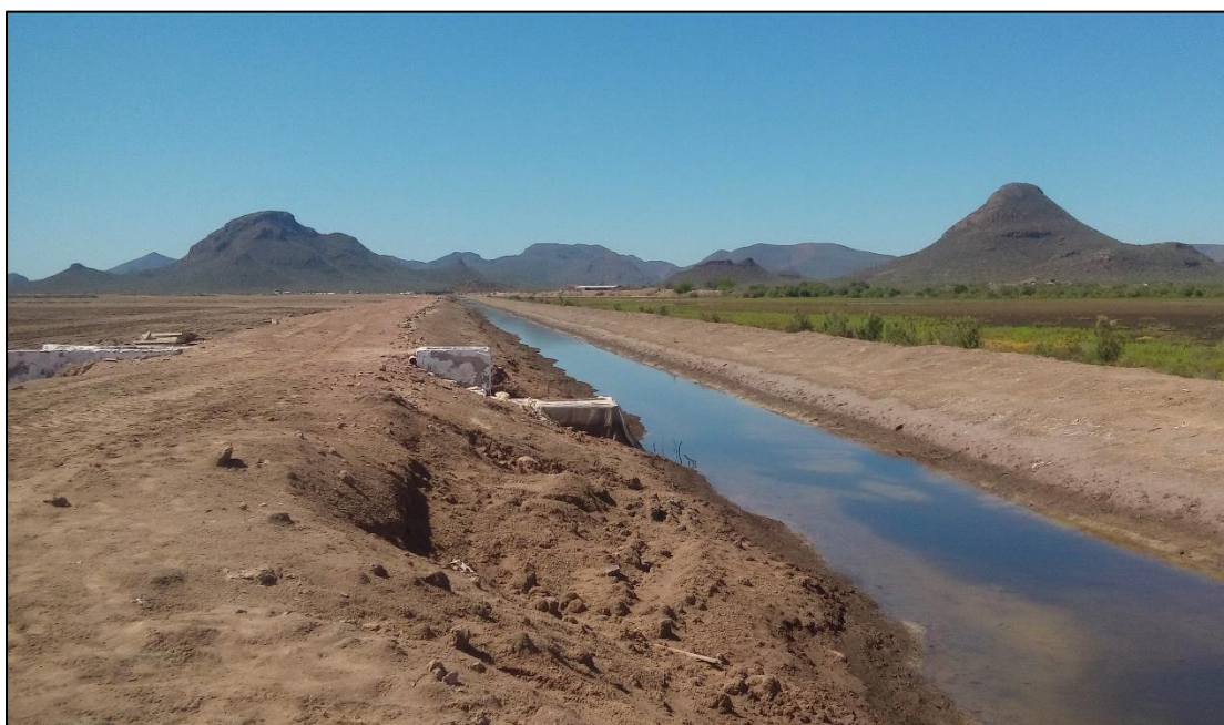
Fotografía 6. Canal de descarga de la granja acuícola colindante al proyecto.
