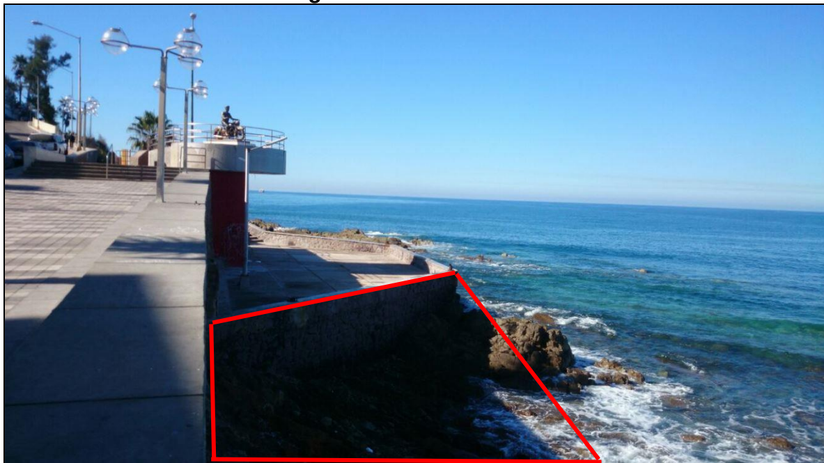
Fotografía II.3. Área a rellenar.
