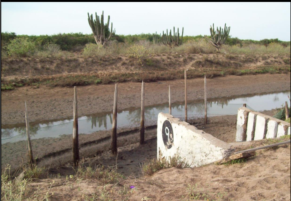
Canal reservorio y mallas excluidoras colocada en la compuerta de entrada del estanque No. 9. Al fondo vegetación de selva baja espinosa caducifolia.
