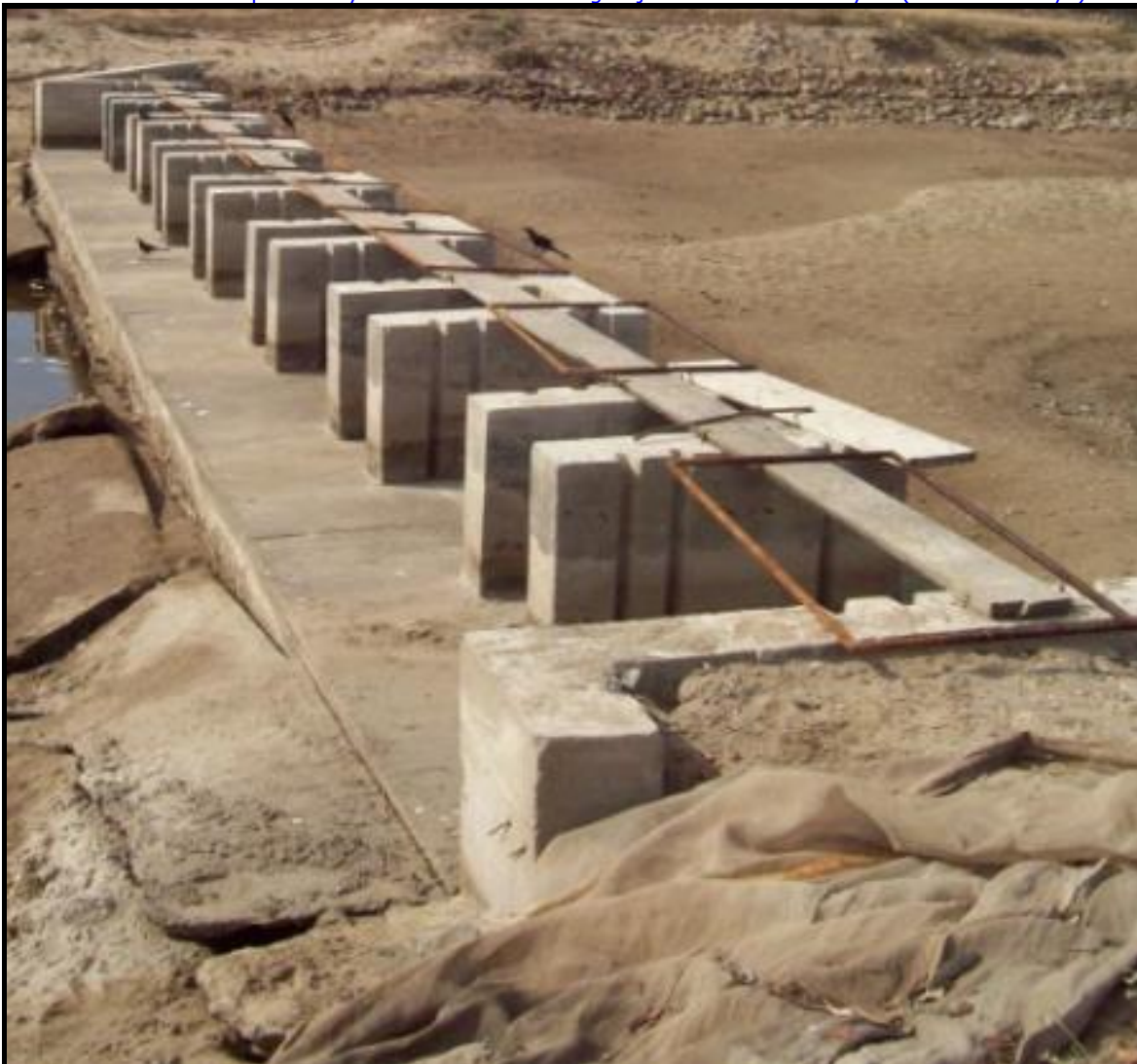
Sistema de exclusión de fauna acuática instalado en la granja.
