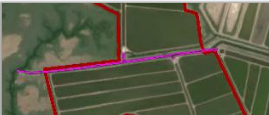
Ilustración 29.- Toma de agua marina, estero aportador “Cangilones”
