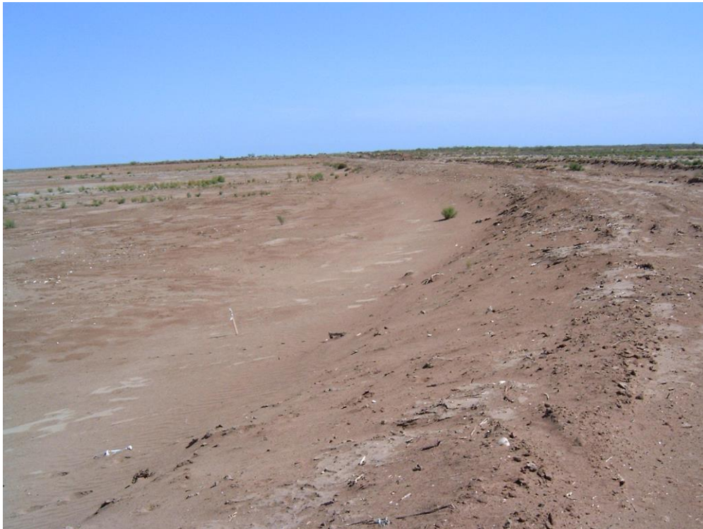
Estanque sin terminar de construir en el Ejido Liliba
