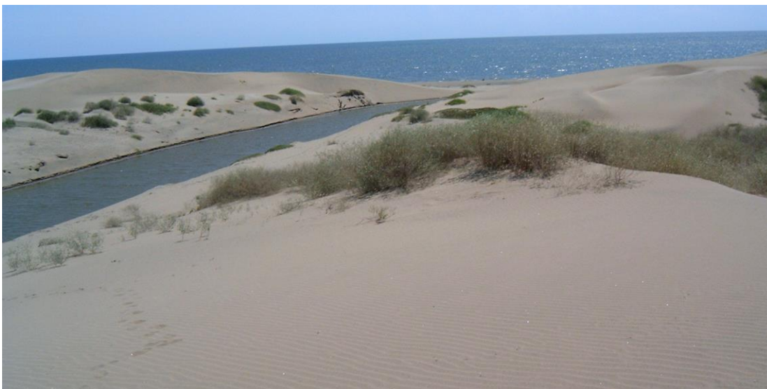
Vista de corte en duna para salida de dren de descarga
