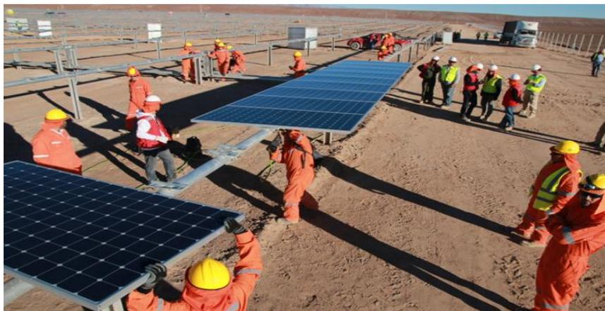
Figura 9. Módulos sobre los seguidores solares
