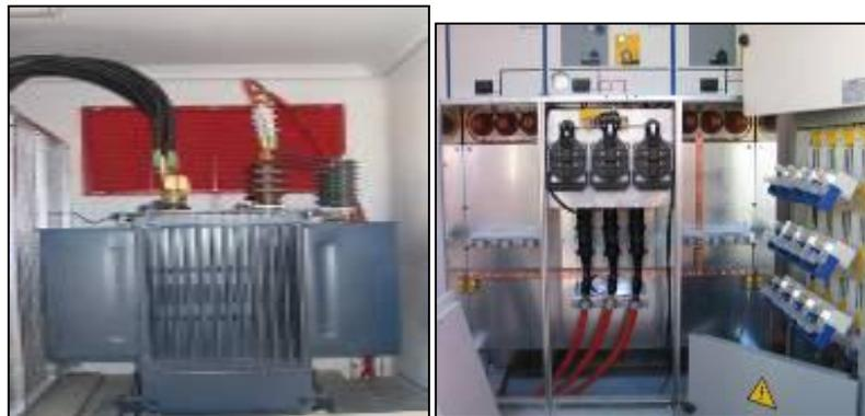
Figura 13. Transformador y celdas de media tensión
