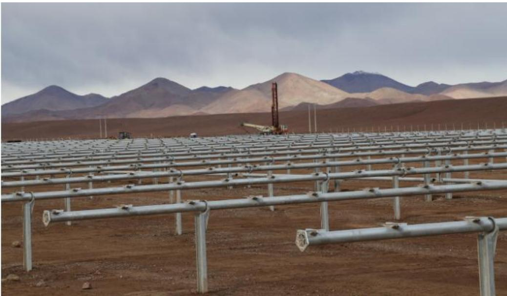
Figura 7. Instalación de tubos de rotación
