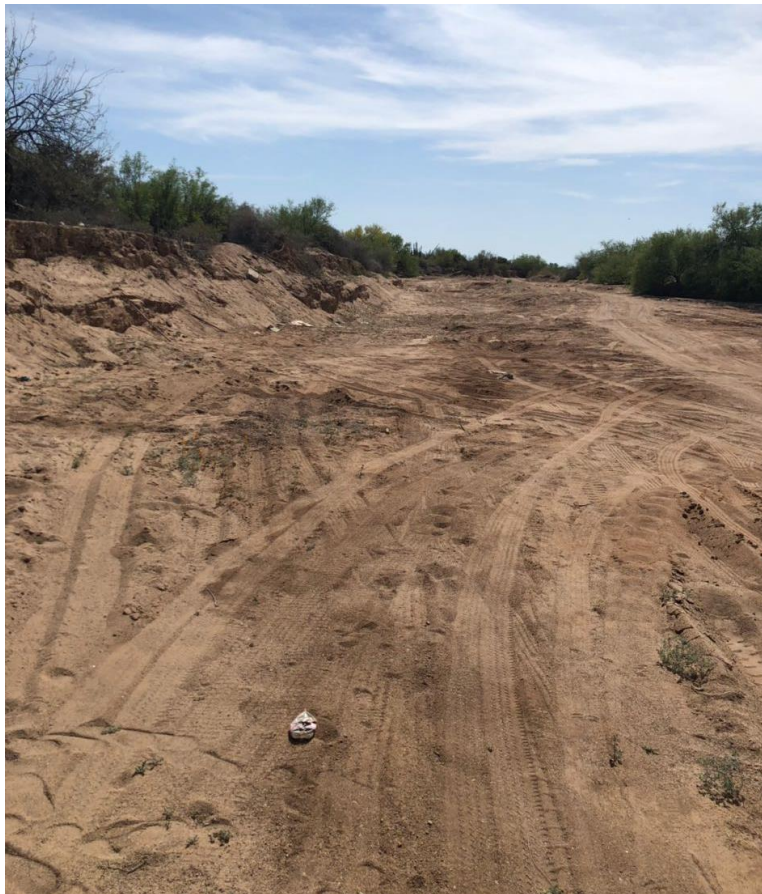
Vista del material pétreo a provechar.
