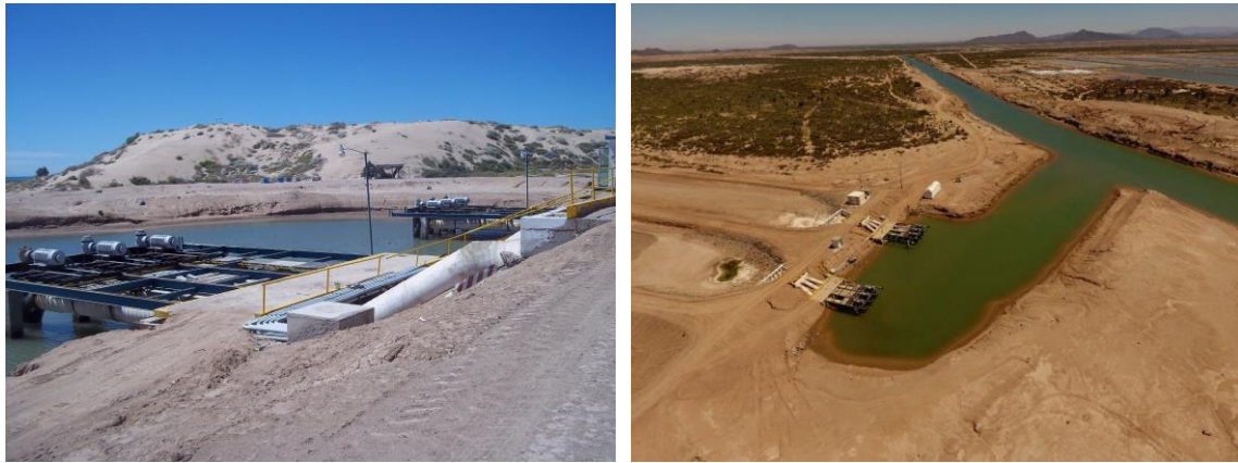
Vista del cárcamo de bombeo
