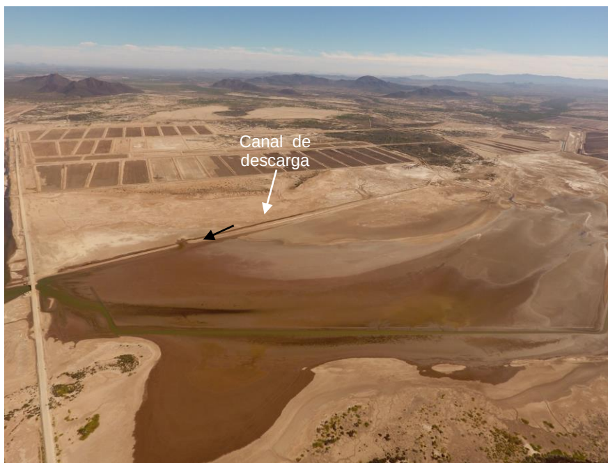
Colector común de descarga de agua residual hacia el estero tastiota.
