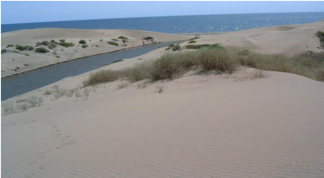
Vista de corte en duna para salida de dren de descarga
