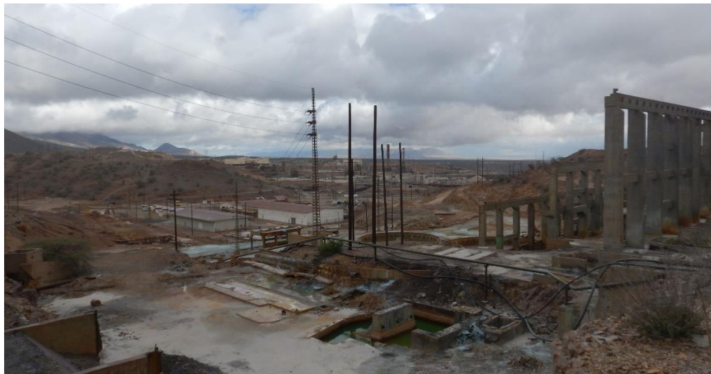
Figura 4.18. Las actividades del complejo minero metalúrgico que han impactando al suelo natural.
