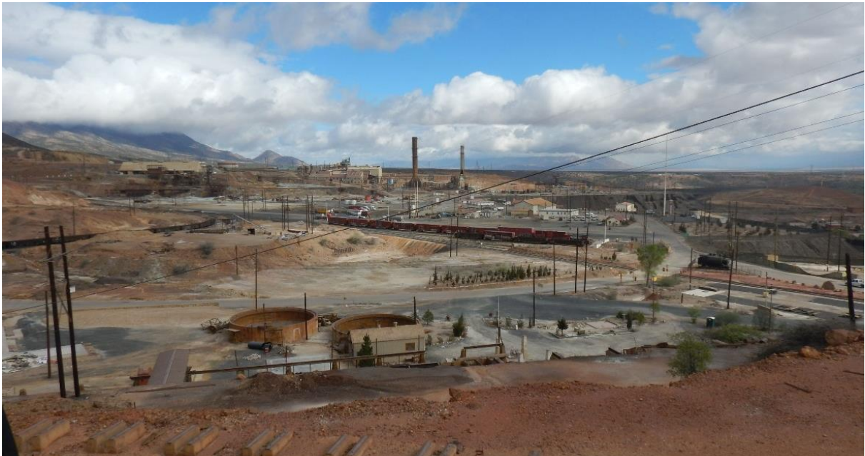
Figura 2.7. Vista panorámica del área dentro de las instalaciones del complejo minero metalúrgico de Buenavista del Cobre, para la construcción y operación del Proyecto.
