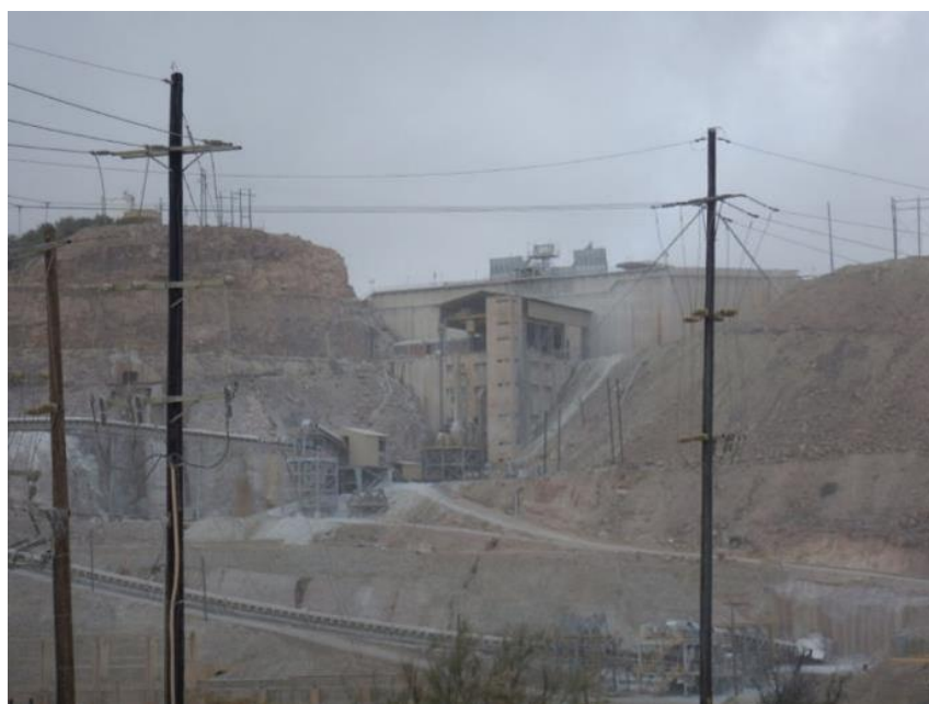
Figura 6.3. Vista a la quebradora al oeste del sitio del Proyecto, observándose una cuenca visual delimitada y una calidad paisajística baja con nulos elementos de origen natural.
