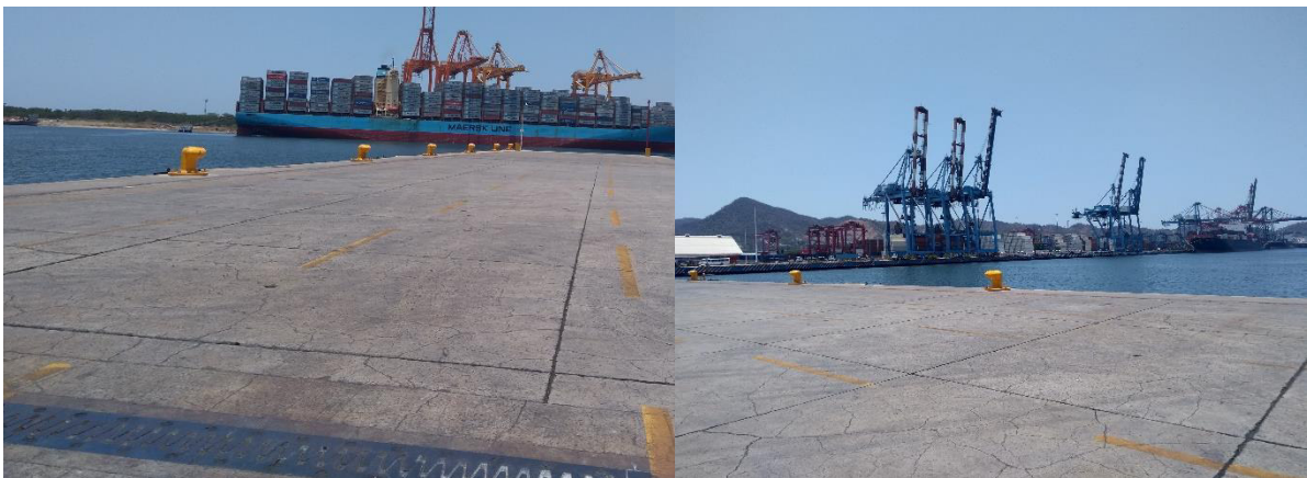
Ilustración No. II. 3. Tramo 15 del puerto interior
