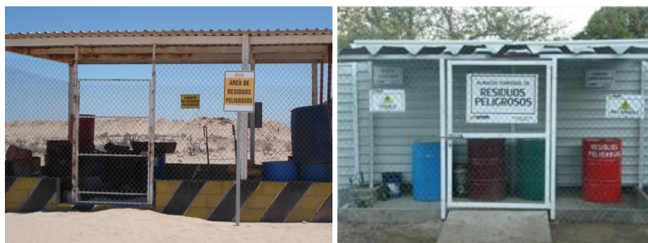
Figura No. 8. Ejemplos de bodegas de almacenamiento temporal de residuos peligrosos.
