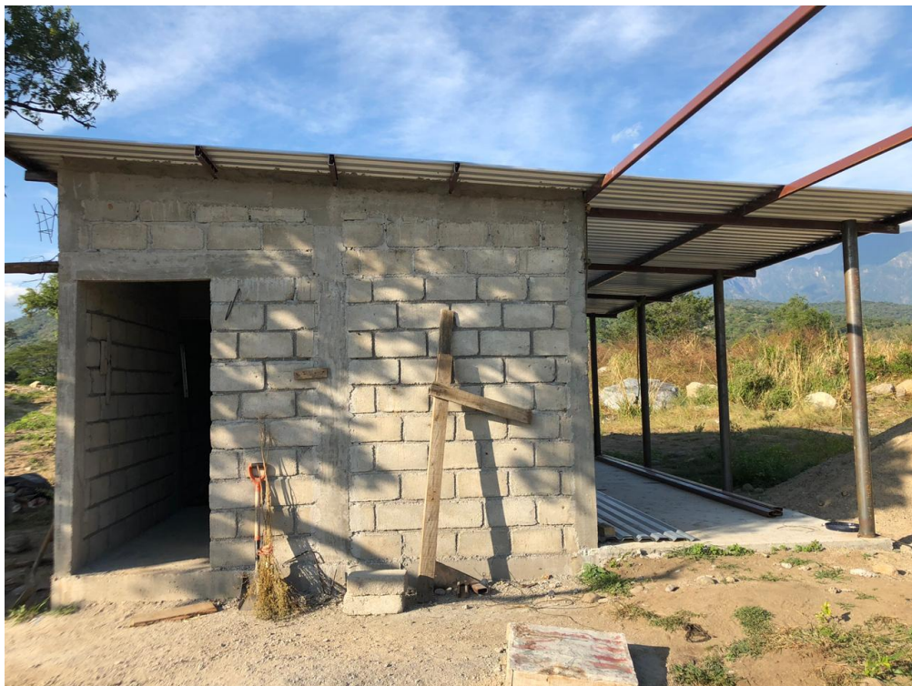
Bodega y Almacén de Residuos Peligrosos
