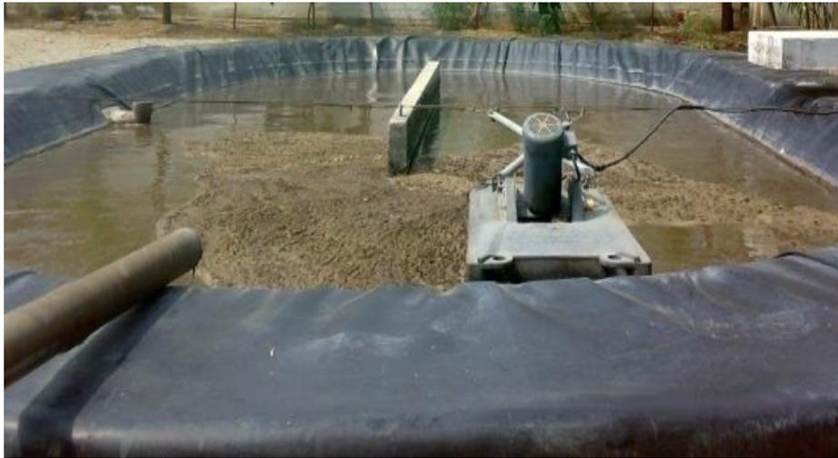
Imagen 16. Digestor de lodos.
