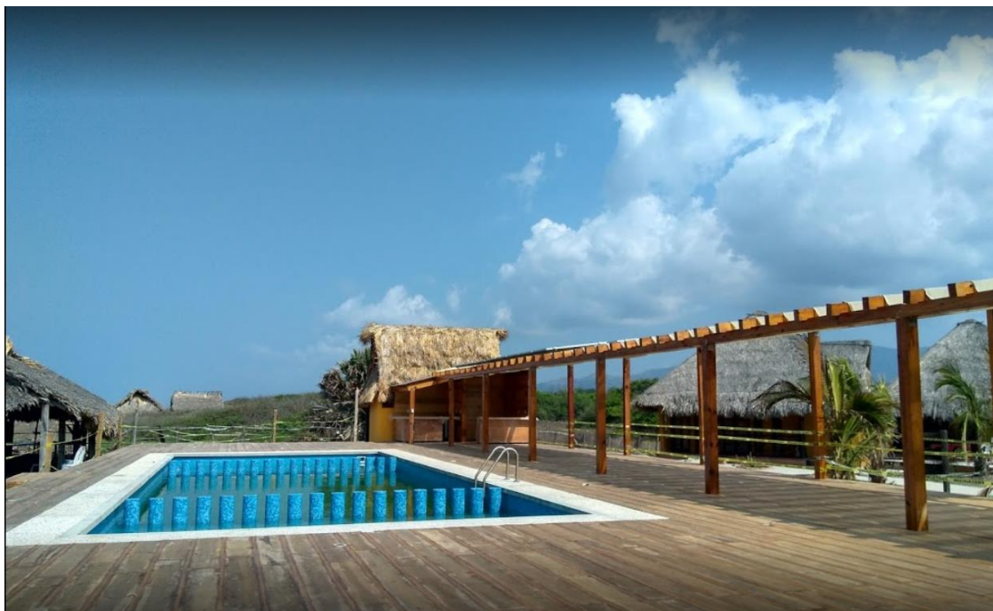
Figura 16: vista final de la Alberca
