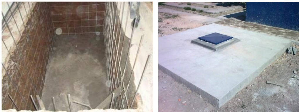
Figura 14: Ejemplo de construcción de cisternas.
