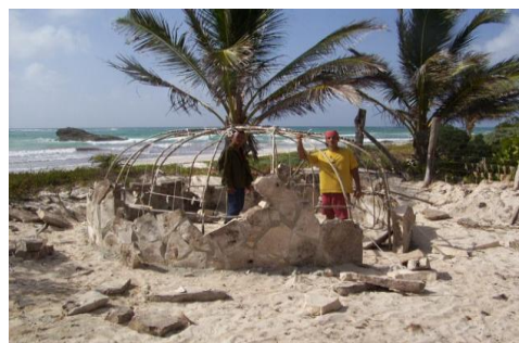
Figura 13: Vista de la forma de construcción del temazcal.
