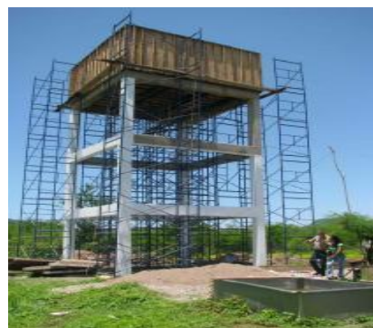
Figura 15: Ejemplo de construcción de tanques elevados.
