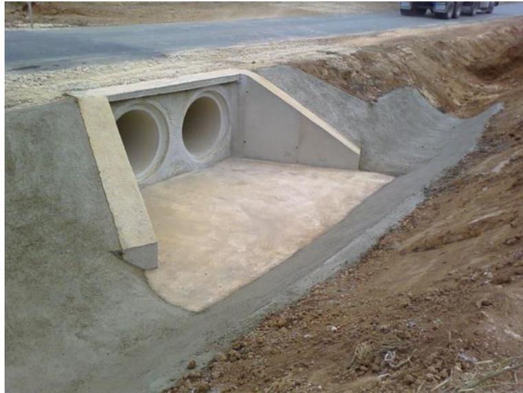
**Figura 6. Ejemplo grafico de una obra de drenaje**
