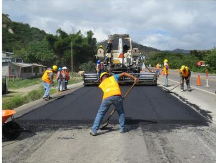
**Figura 7. Formación de capa con la mezcla asfáltica**
