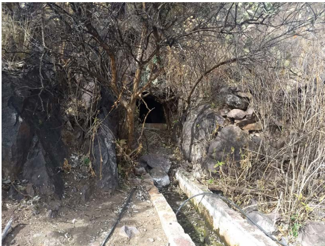
Ilustración 2.- Entrada principal a mina Real Viejo
