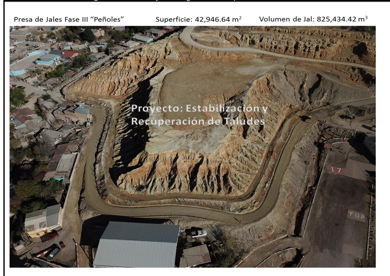
Figura II-1. Presa de jales antigua de la Compañía Minera Peñoles
