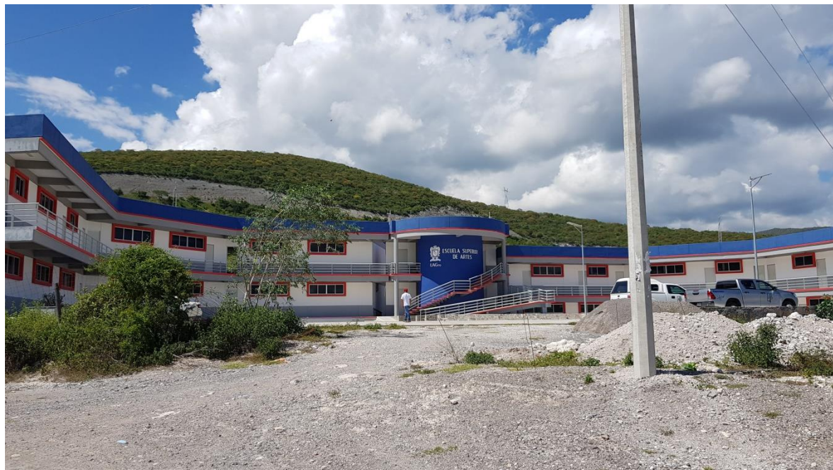
Foto 6. Edificio en construcción.
