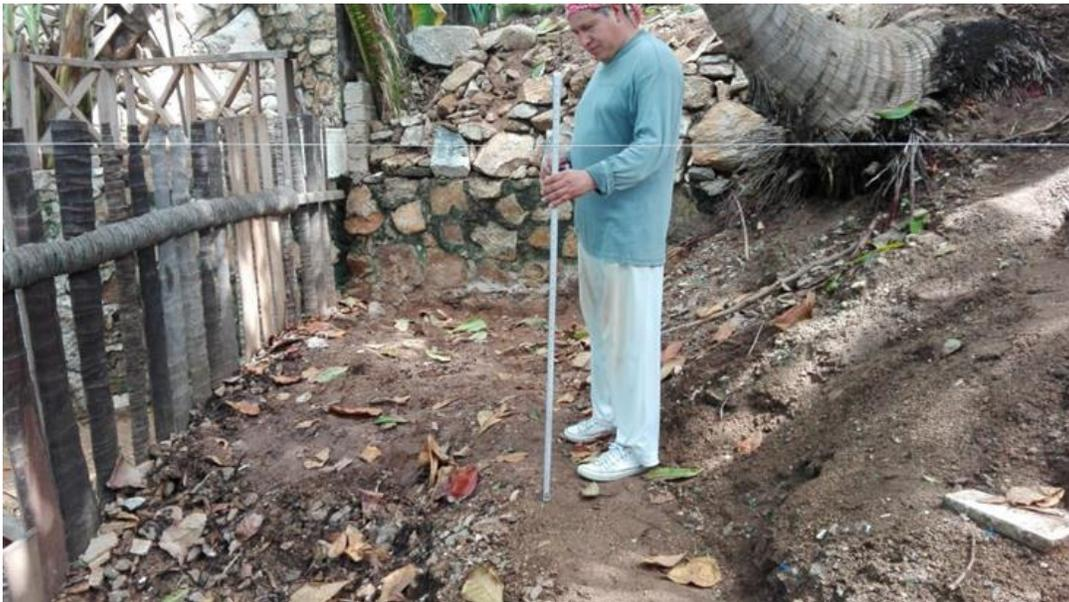
Imagen 8.- Lugar en el que estarán ubicados los muros de contención, formando un ángulo recto, el nivel en el que se encuentra el cordón, será la altura que tendrá cada muro.
