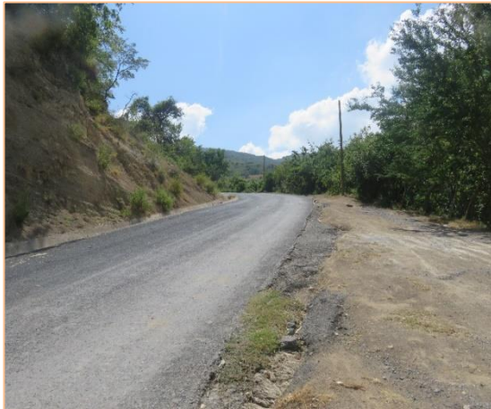
Fotografía 3. Vialidad que conduce hacia las zonas de aprovechamientos, la cual se encuentre en buenas condiciones
