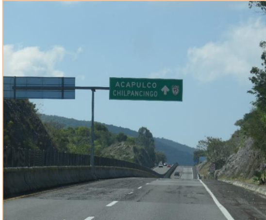
Fotografía 1. Autopista del Sol, que conduce al entronque hacia la localidad de Axaxacualco.
