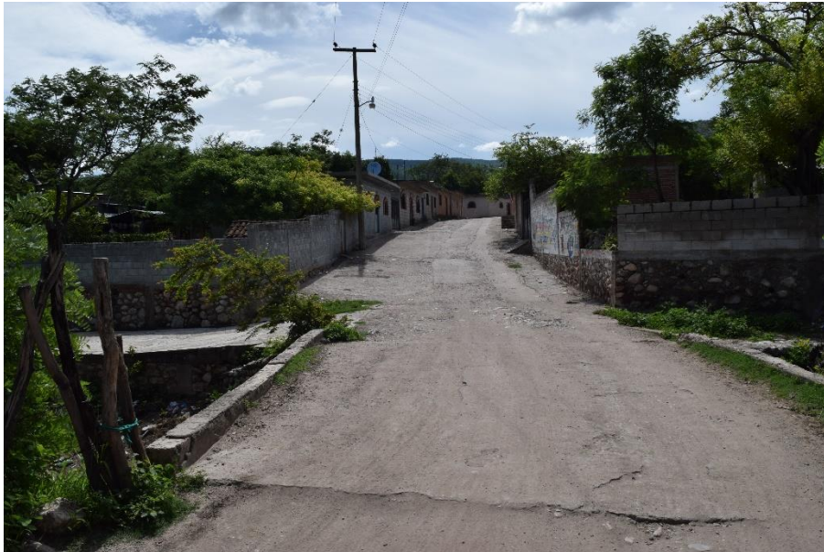
Foto 5. Condiciones de las vialidades al interior de la comunidad de Temalac
