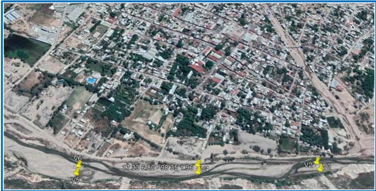
Vista de de vialidades que comunican con el sitio de extracción de material.
