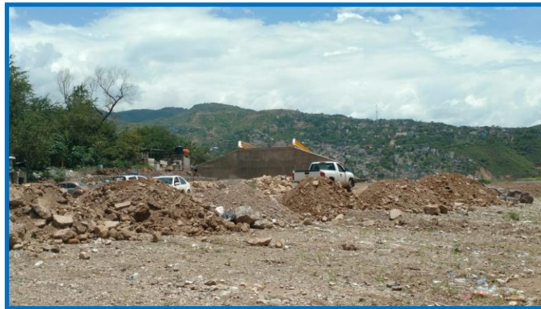
Foto 2. Colindancia sur, boulevard en construcción.
