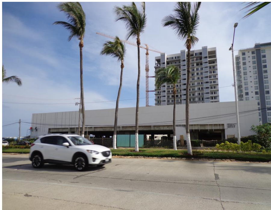
AF-04. Panorámica de la Carretera a Barra Vieja. Se observa la amplitud de la sección vial, la vegetación sembrada sobre el camellón central, consistente en palmeras de coco y el alumbrado público existente, colocado a cada 30 metros aproximadamente.
