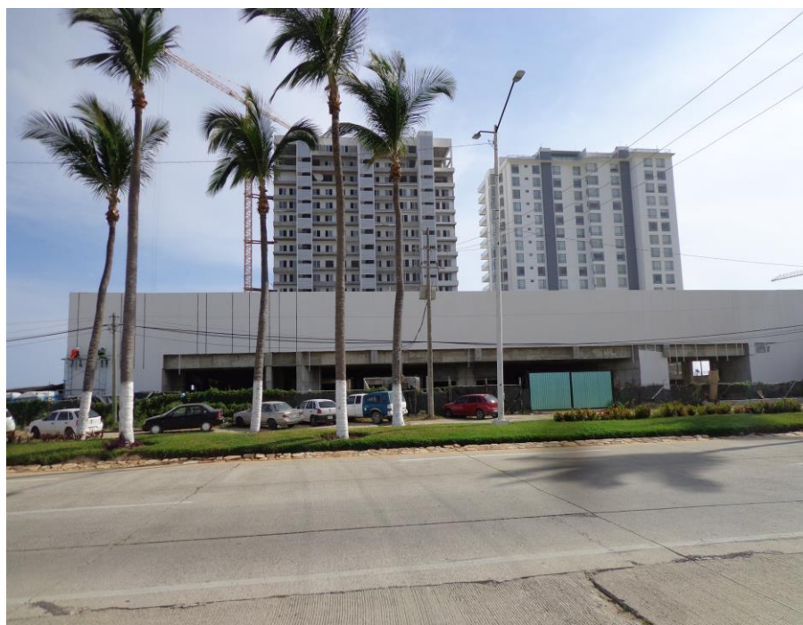
AF-03. Panorámica desde la vialidad de Acceso (Carretera a Barra Vieja). Se observa el condominio BAYAM Residences Acapulco en proceso de construcción.
