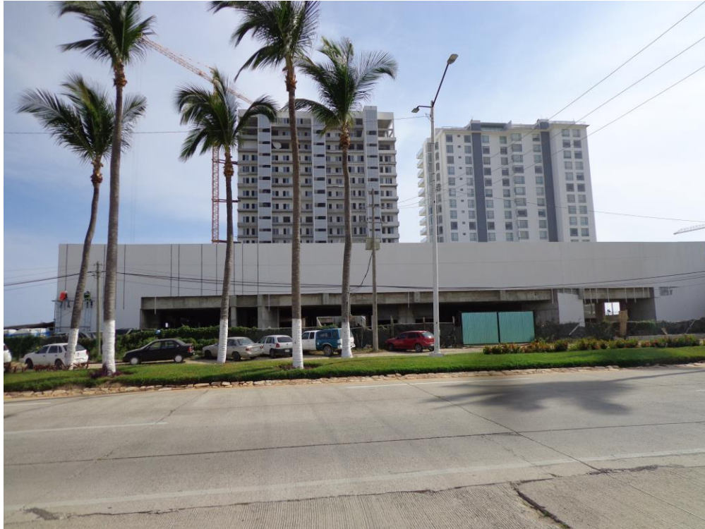
Imagen II.2. Inferior. Panorámica de la Carretera desde el Oriente. Imagen II.1. Superior. Carretera a Barra Vieja frente al predio.
