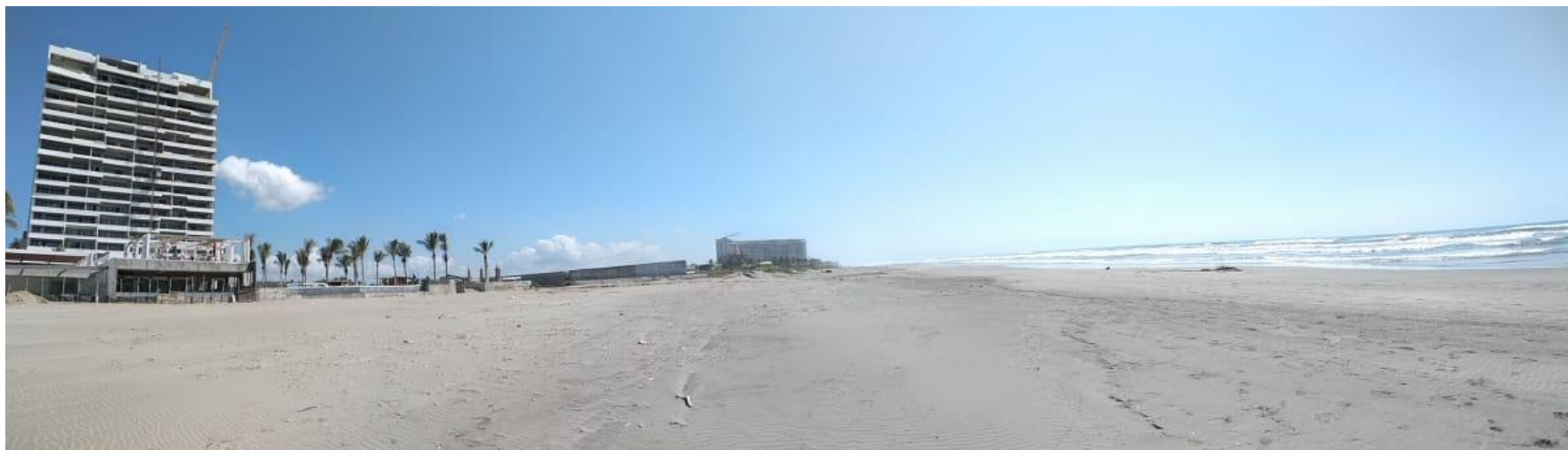
AF-05. Panorámica del predio desde el fondo de la Zona Federal Marítimo Terrestre, Se aprecia la ausencia de especies arbóreas. Se observa al fondo el condominio en construcción BAYAM Residences Acapulco.
