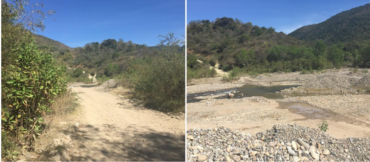
Ilustración 39. Vista general del Proyecto de construcción
