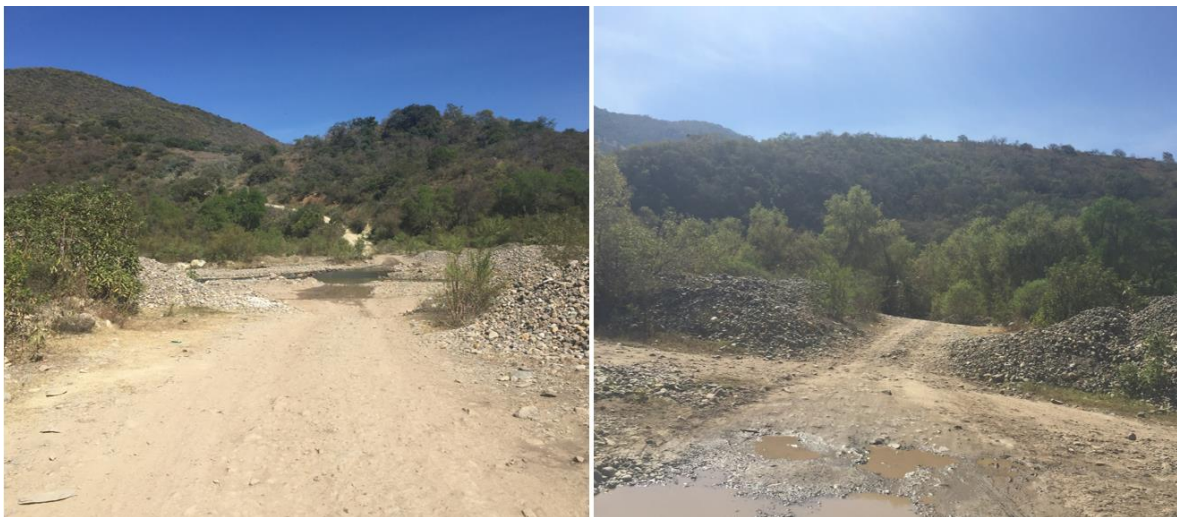
Ilustración 38. Acceso 2 del Puente Vehicular Itacúan
