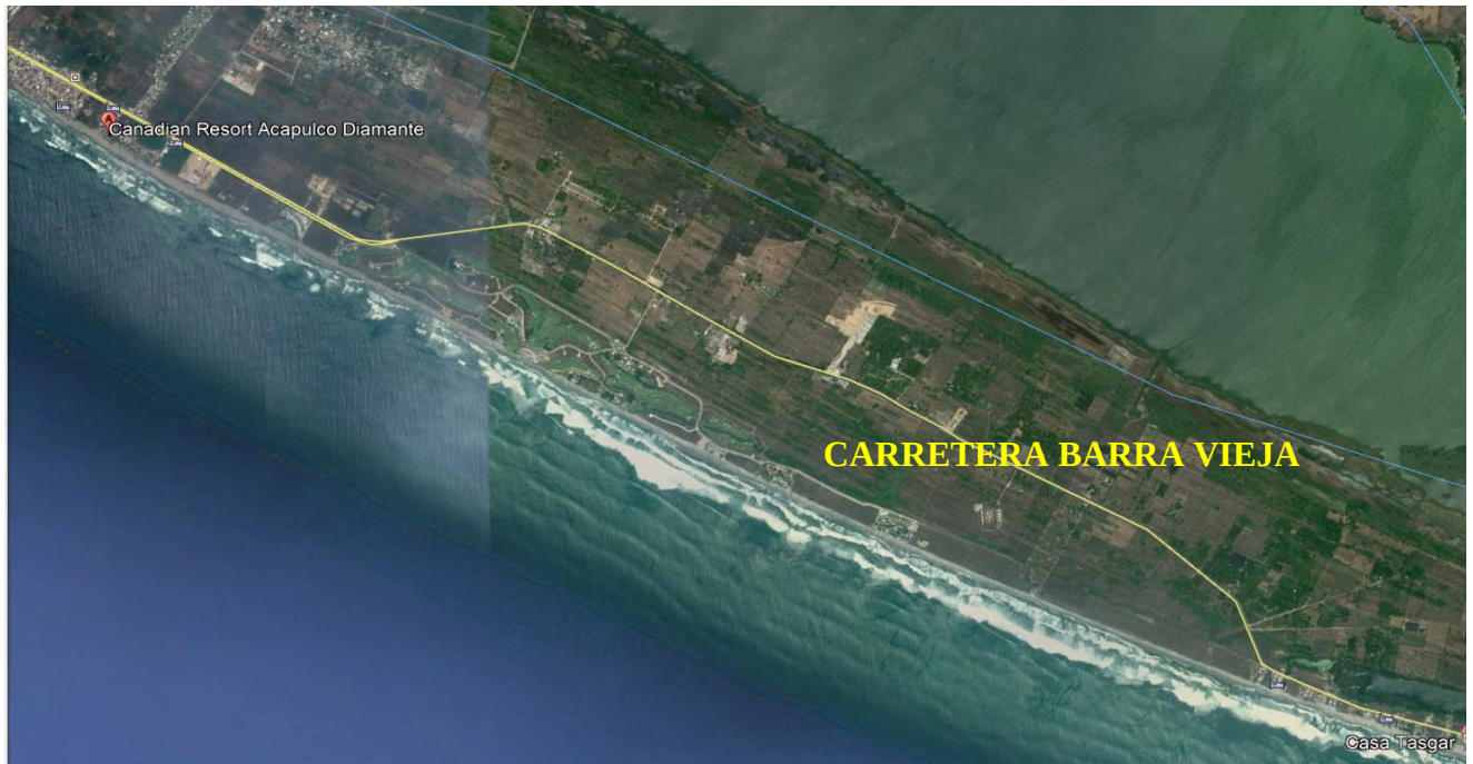
Imagen 13 Vías de acceso
