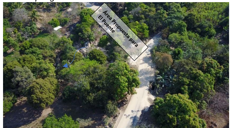
Imagen 6. Vista Suroeste a Noroeste Aguas abajo del área propuesta para construcción del Puente
