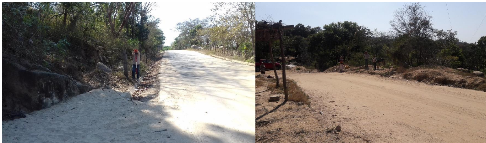
Fotografía 11 y 12. Vistas del camino a base asfalto proveniente de Huixtepec y el camino de terracería con concreto hidráulico que conduce a la localidad rural La Guadalupe.
