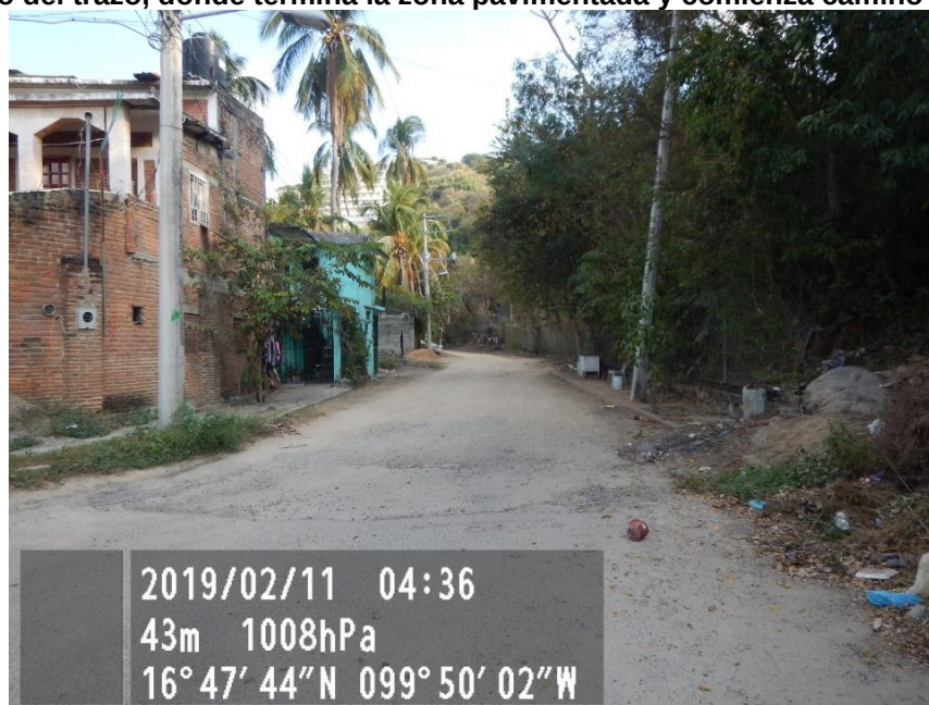
Foto 1. Inicio del trazo, donde termina la zona pavimentada y comienza camino de terracería.
