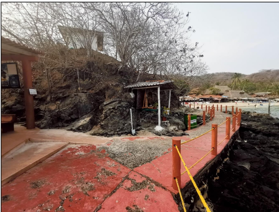
Imagen 06. En esta imagen podemos apreciar las condiciones actuales de deterioro ambiental que prevalecen en el sitio.
