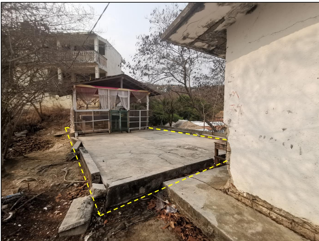
Imagen 26. Este es el estado actual que presenta el área sobre la cual se desarrollara el proyecto que, en términos generales, se encuentra vegetación de segundo crecimiento no inducida propia de zonas costeras. Además, como se puede observar se encuentran construcciones en avanzado estado de deterioro.
