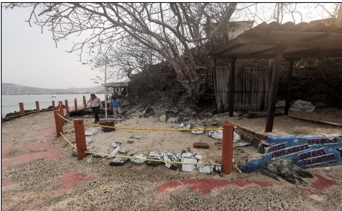
Imagen 30 Presenta las condiciones actuales del módulo existente, mismo que será retirado para la construcción del propuesto en el presente estudio.
