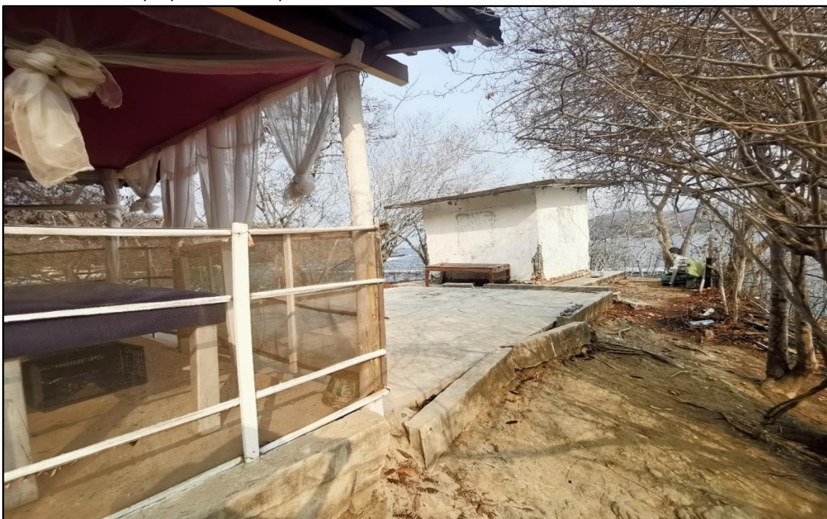
Imagen 31. Muestra otra perspectiva del sitio sobre el que se construirá la cabaña y del que se pretende el retiro de las obras existentes dado su estado actual de deterioro.
