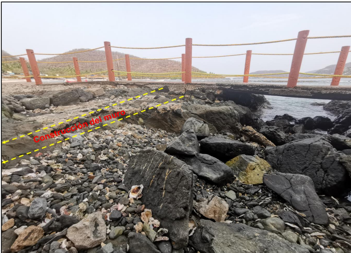
Imagen 02. Muestra el sitio donde se ubicará el muro de mampostería de piedra natural.
