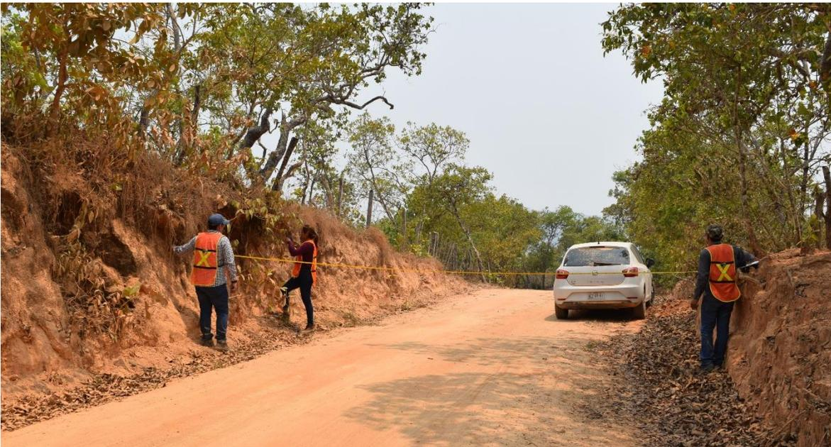
Fotografía 12. Vista frontal a la altura del Km 3+000 durante el proceso de medición del ancho total del camino; nótese la nula vegetación forestal primaria dentro del camino, es de resaltar que en algunos puntos se requerirá de ligeros cortes solo para afinar los taludes existentes.
