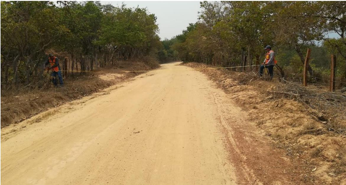
*Fotografía 14. Vista frontal a la altura del Km 2+000 durante el proceso de medición del ancho total del camino; nótese la nula vegetación forestal primaria dentro del camino, y la abundancia de especies rastreras colindante a los predios cercados al camino, es de resaltar que en algunos puntos se requerirá de la poda de la copa de algunos árboles ubicados sobre los corrales colindantes.*
