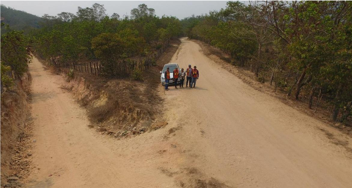
*Fotografía 13. Vista aérea tipo frontal del Km 1+960 al 2+080, en el cual se puede apreciar el ancho existente del camino que se pretende pavimentar; nótese como en un tramo de casi 120 metros lineales no se encuentra vegetación forestal primaria dentro del camino.*
