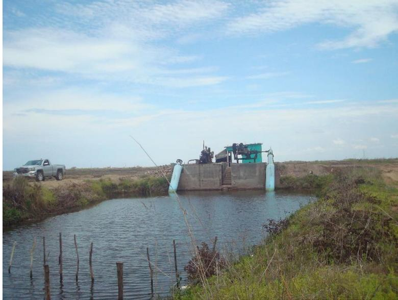
Canal de alimentación al Cárcamo de bombeo, el motor de la izquierda abastece de agua al reservorio y de este se alimenta al grupo de estanques 1 al 8 de la granja.
