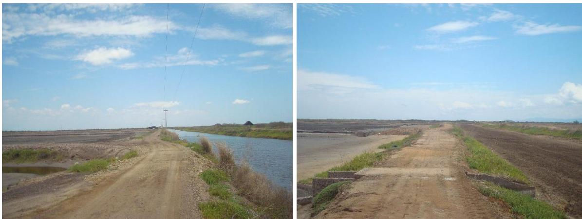
Imagen izquierda, se observa bordería del estanque uno y dos que se utiliza además como camino, en la margen derecha se observa el dren de descarga principal de la granja. Imagen derecha al centro bordo que se aprovecha como camino para vehículos, delimita el estanque cinco y reservorio.
