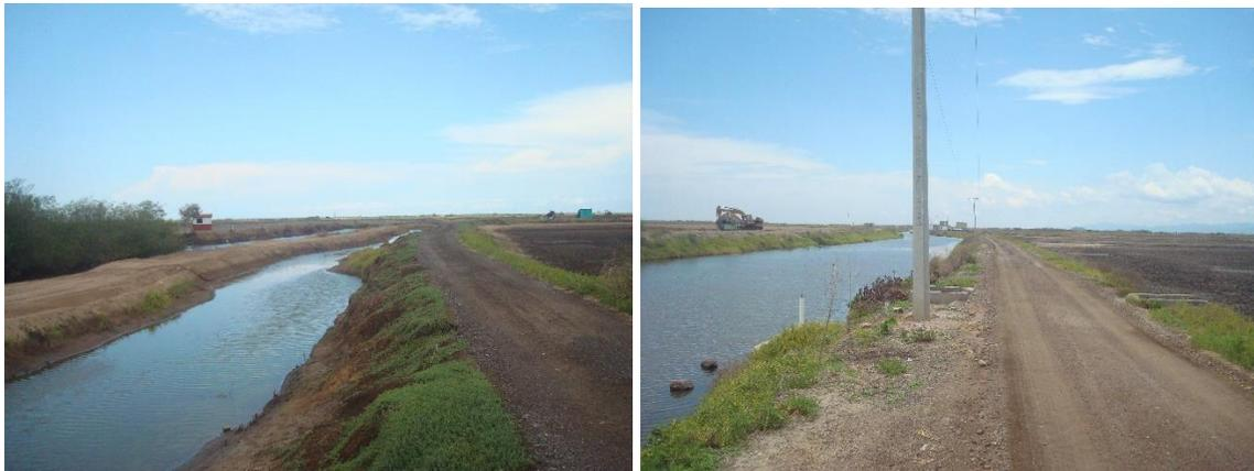
Izquierda, corresponde a una vista parcial del dren de descarga de los estanques 6,7 y 8 cruza la canal de llamada por medio de tubo de diámetro mayor por el bordo sur del reservorio y cárcamo de bombeo, continua hasta el dren principal (Imagen derecha) en el que descargan los estanques 5, 4, 3, 2 y 1.
