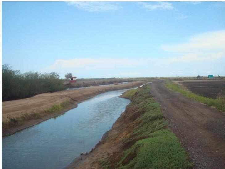
Dren de descarga de los estanques 6,7 y 8 de la granja, se observa incipiente vegetación halófila sobre el talud, por lo que se prevé el establecimiento inducido con mangle para estabilizar y conservación del talud del dren y aporte al hábitat de especies silvestres.
