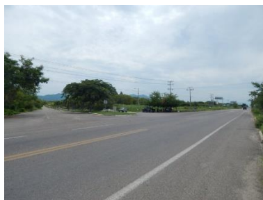
Vista de la Carretera Punta de Mita - La Cruz de Huacacitlé
