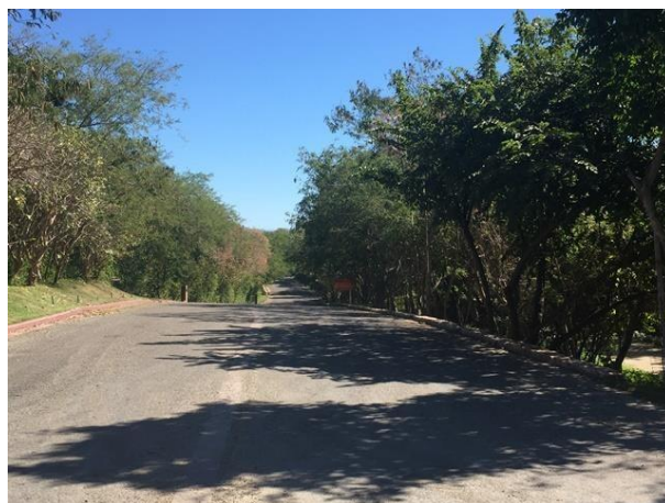
Vista de la vialidad Punta Mita, la cual se conecta a la Carretera Punta de Mita – La Cruz de Huanacaxtle.
