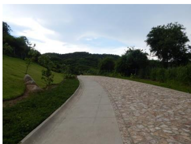
Vista de la "Vialidad 1" colindante al sur del predio
