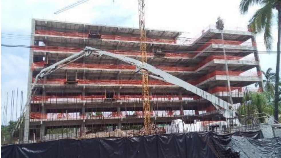
Figura 3. Condición actual del sitio del proyecto y avance de obra del proyecto.
