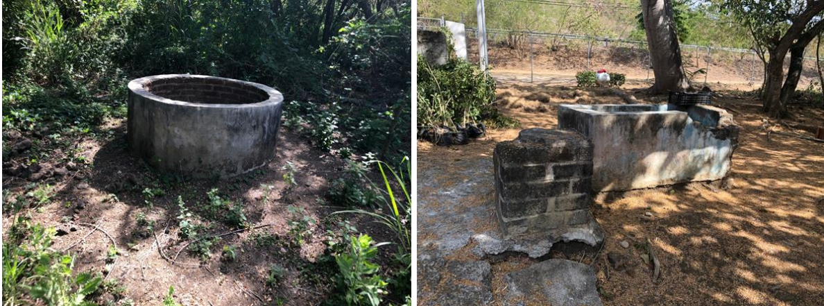
FIGURA II. 5 POZO DE AGUA Y PILETA
