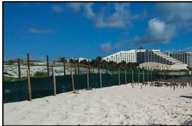
Ilustración VI.2 Tipo de valla a instalar con troncos de madera y malla sombra
