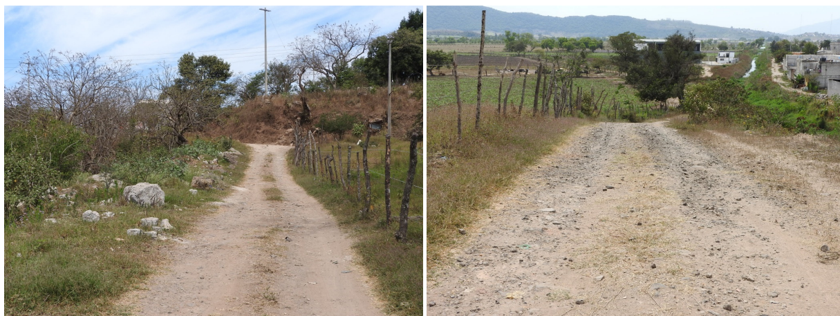
Figura IV-1. Condiciones del área de influencia del proyecto
