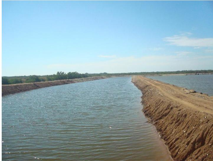
Vista de este a oeste del canal reservorio sobre el bordo del estanque cuatro. Derecha bordo del estanque cuatro, el ancho de corona permite el paso de vehículos para la operación de la granja.
