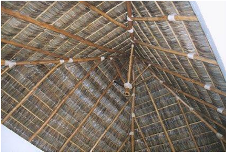
ILUSTRACIÓN III-15. EJEMPLO DE LA ESTRUCTURA DE LA PALAPA.
