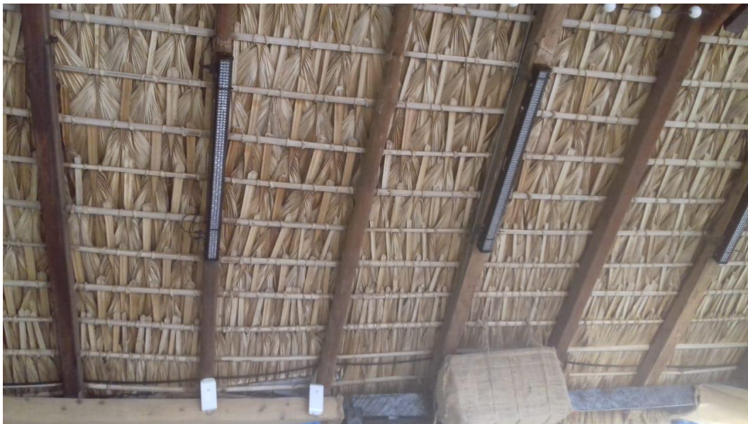
ILUSTRACIÓN III-5 PALAPAS 1 Y 2 Y MATERIAL CON EL QUE ESTÁN CONSTRUIDAS
