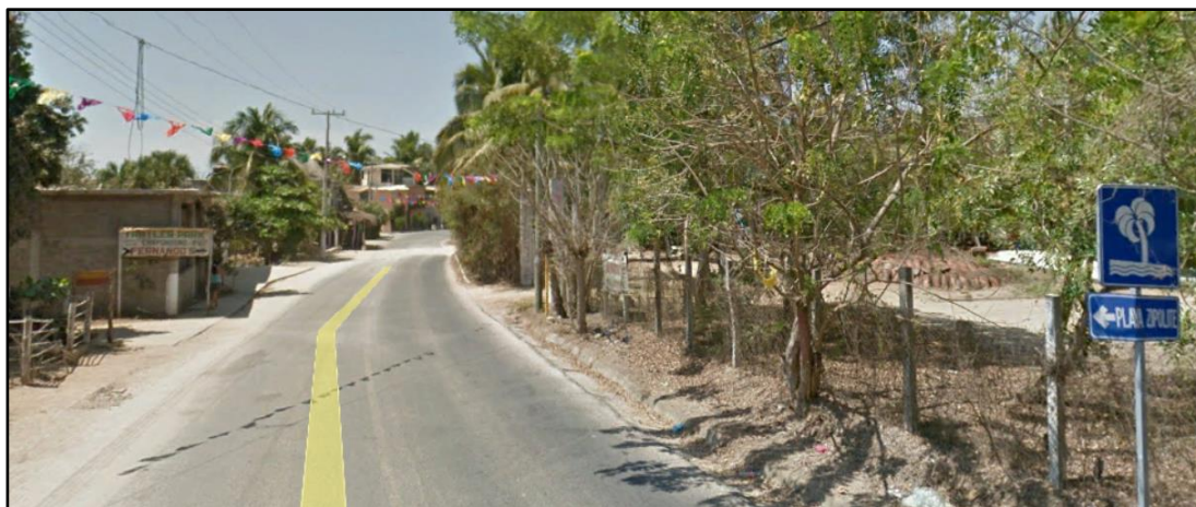
Fig. IV.9. Principal vía de comunicación Carretera costera federal No. 175
