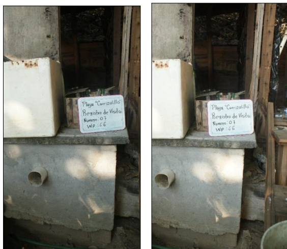
Ilustración II-99 Localización del Registro de Visita.
