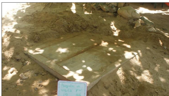
Ilustración II-82 Localización del Registro de visita.
