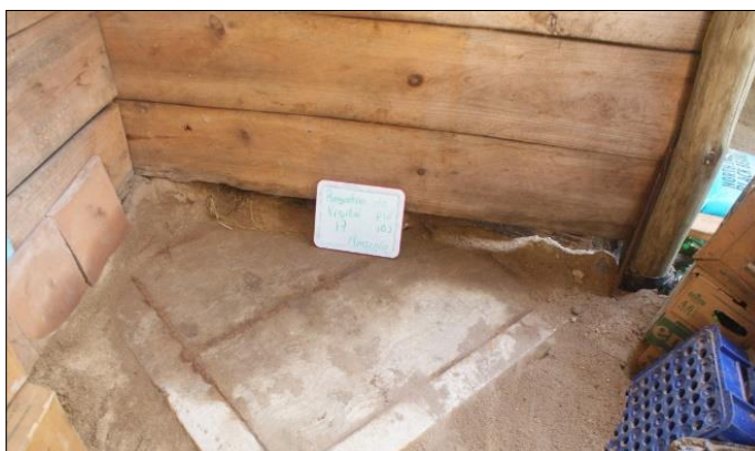
Ilustración II-80 Localización del Registro de visita.
