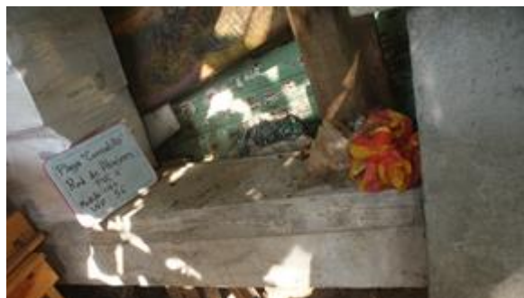
Ilustración II-92 Red de Atarjeas de 4" encofrada.
