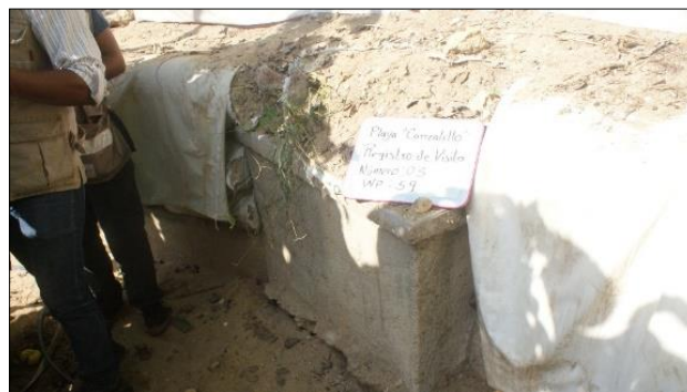
Ilustración II-95 Localización del Registro de Visita.
