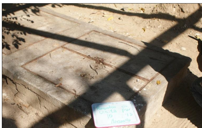
Ilustración II-73 Localización del Registro de visita.
