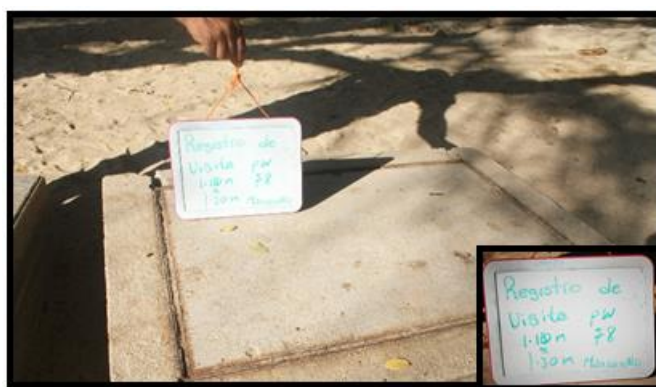
Ilustración II-65 Localización del Registro de visita.
