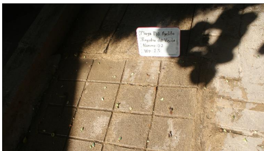
Ilustración II-12 Localización del Registro de Visita.
