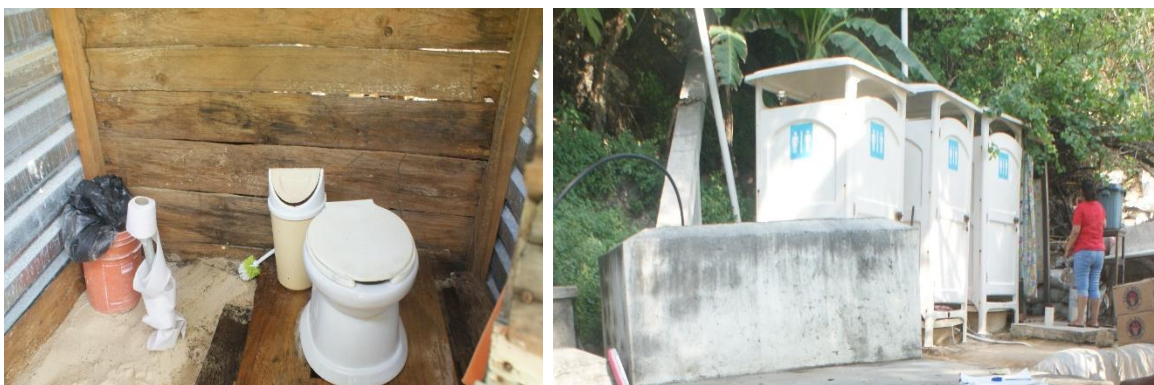
Ilustración II-1 Condiciones deplorables de las instalaciones sanitarias funcionando en las tres playas.
