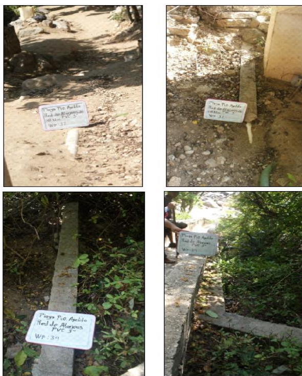
Ilustración II-46 Red de Atarjeas de PVC de 3” de concreto encofrada.
