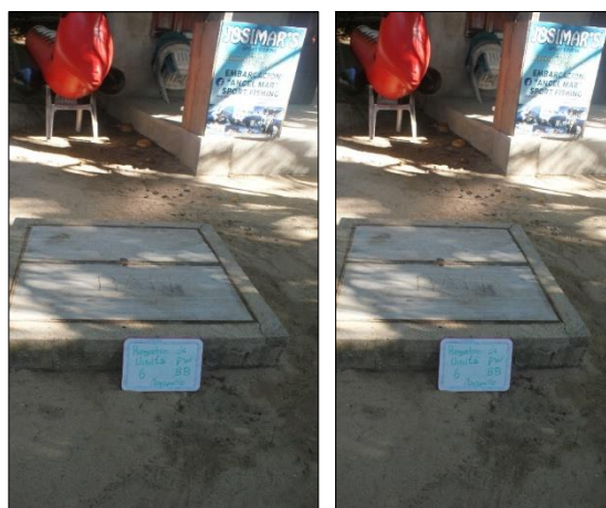
Ilustración II-69 Localización del Registro de visita.
