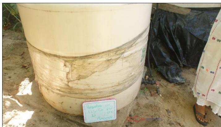
Ilustración II-76 Localización del Registro de visita.
