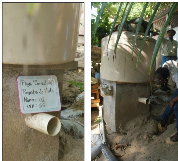
Ilustración II-93 Localización del Registro de Visita.
