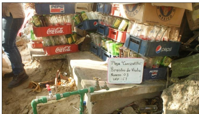
Ilustración II-100 Localización del Registro de Visita.
