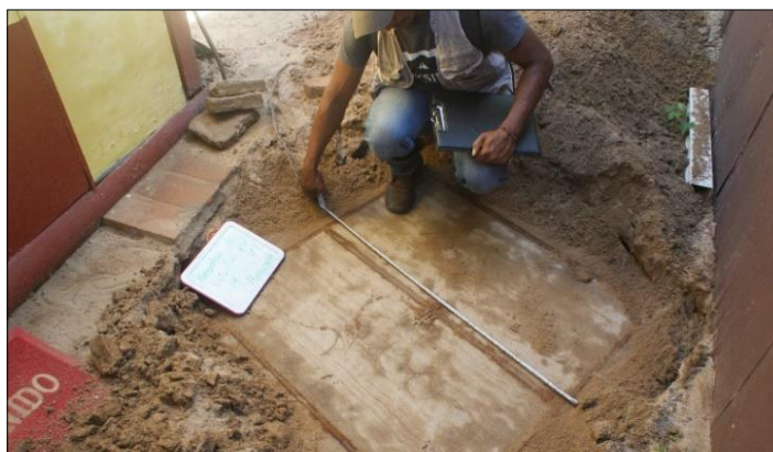
Ilustración II-77 Localización del Registro de visita.
