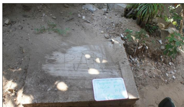
Ilustración II-83 Localización del Registro de visita.
