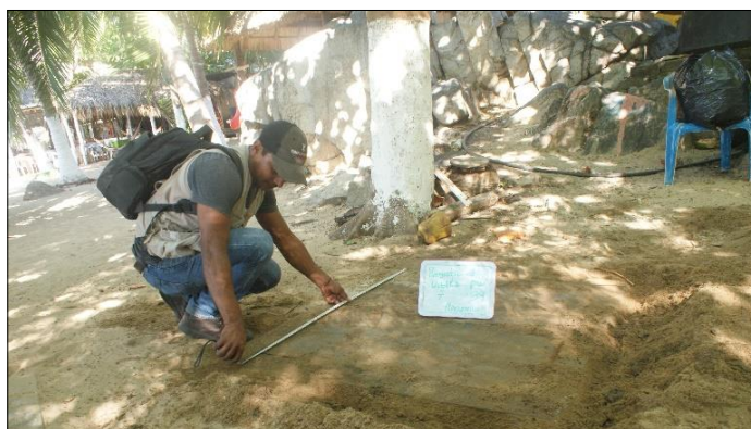
Ilustración II-70 Localización del Registro de visita.
