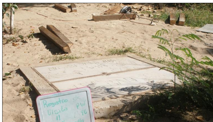
Ilustración II-74 Localización del Registro de visita.
