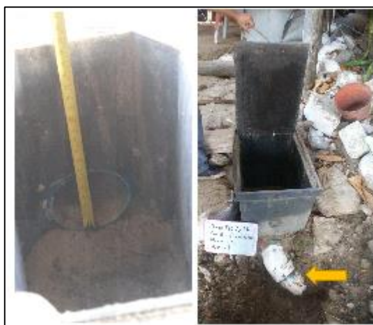
Ilustración II-10 Red de Atarjeas de PVC de 8".
