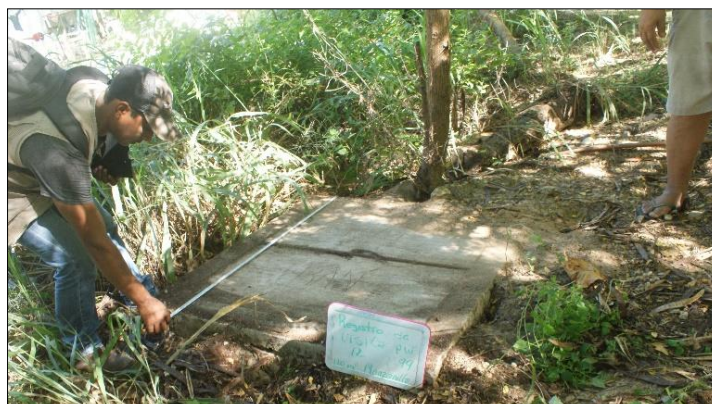
Ilustración II-75 Localización del Registro de visita.
