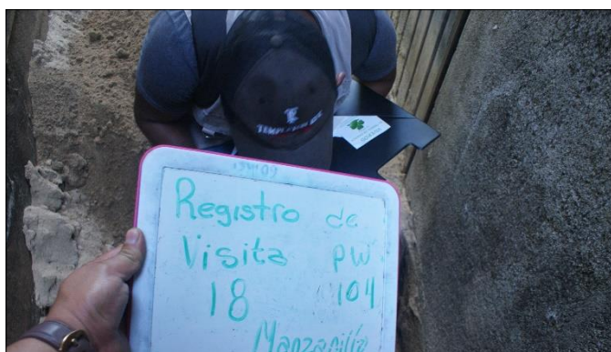
Ilustración II-81 Localización del Registro de visita.
