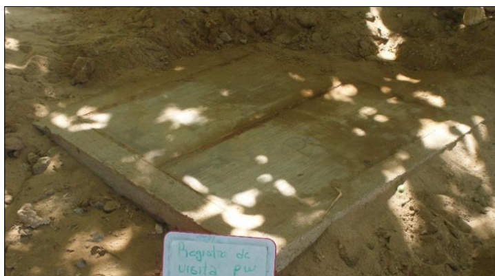
Ilustración II-86 Localización del Registro de visita.
