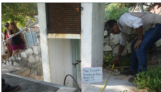
Ilustración II-97 Localización del Registro de Visita.
