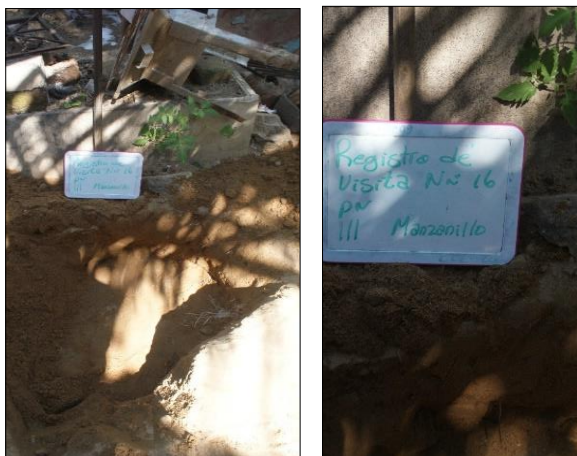
Ilustración II-79 Localización del Registro de visita.
