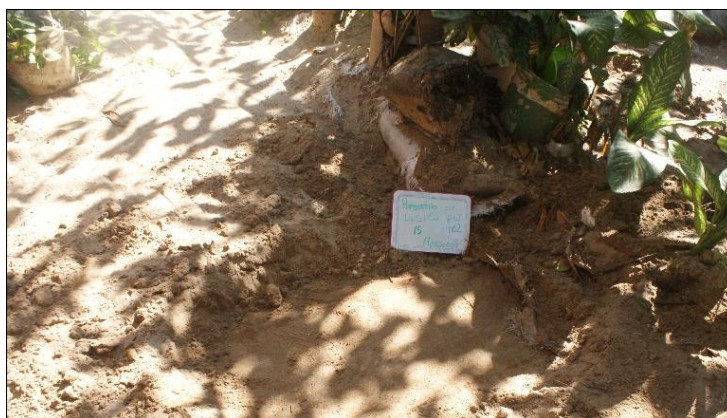
Ilustración II-78 Localización del Registro de visita.
