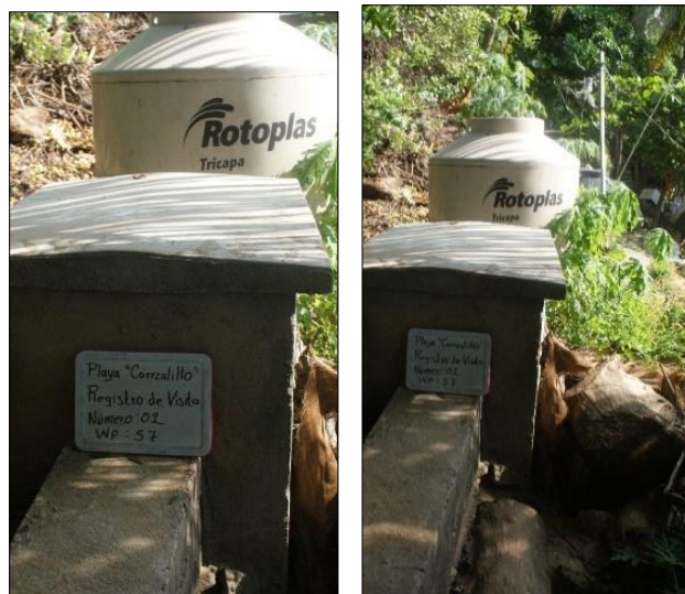
Ilustración II-94 Localización del Registro de Visita.
