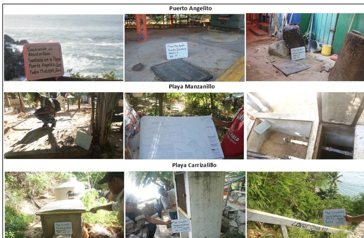
Ilustración II-2 Obras y actividades red de atarjeas, registros de visita, registros domiciliarios y cárcamos en las Playas de Pto. Angelito, Manzanillo y Carrizalillo.
