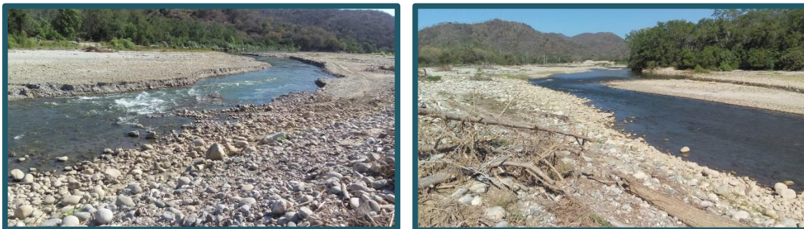
Imagen IV.28.- Cauze actual del río Copalita, posterior a temporada de lluvias.
