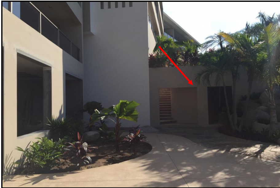
Fotografía 5. En esta zona se sitúa el cuarto de máquinas y la escalera de acceso que comunica a la alberca sección 1 con la alberca sección 2, obras concluidas al 100%.
