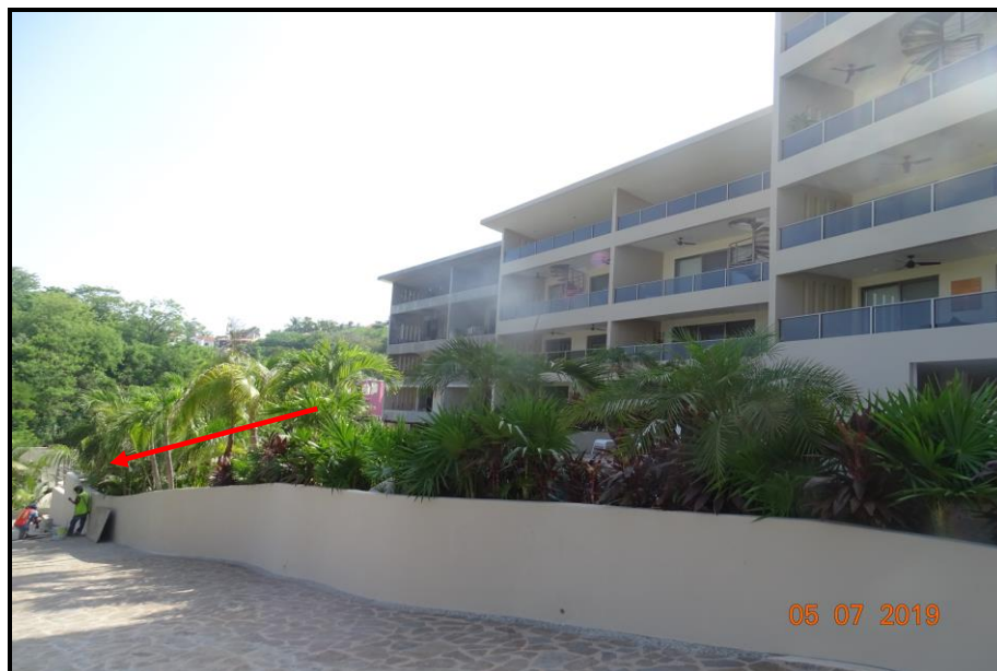
Fotografía 11. Vista de la colindancia Sur del edificio 11-3, con muro perimetral del terreno y andador que conduce a la Playa El Arrocito.
