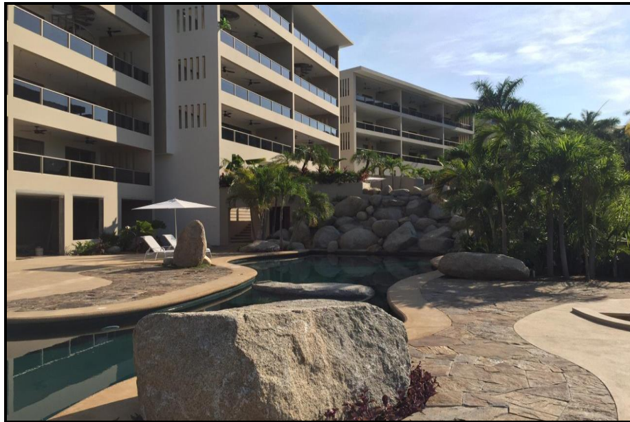
Fotografía 4. Panorama actual de la alberca sección 2; las actividades faltantes consisten en acabados y pintura.
