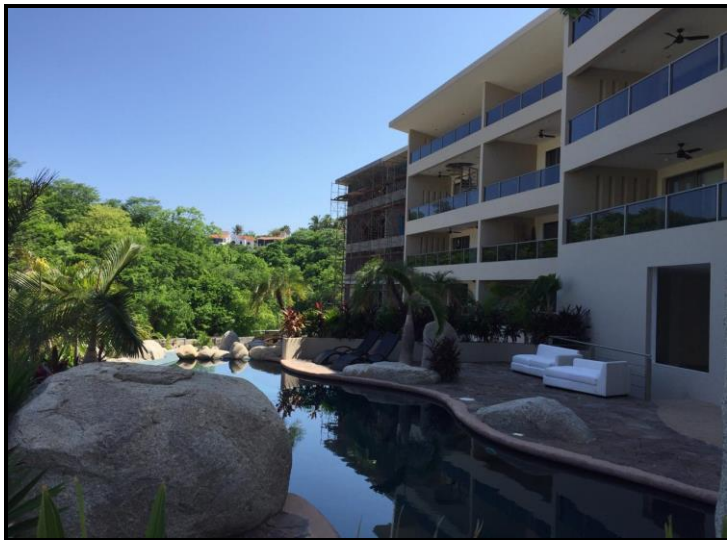
Fotografía 9. La alberca sección 2 se encuentra totalmente construida, la cual se encuentra ya en operación.
