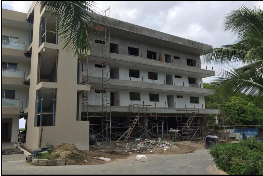
Fotografía 1. Vista actual que presenta el edificio 11-3 y cubo de elevador los cuales llevan un avance del 90% y 95% respectivamente.
