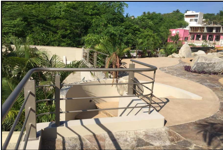
Fotografía 6. Escalera semicircular que conecta al área de alberca con un andador que conduce a la playa; obra terminada y en operación.
