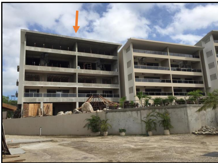
Fotografía 8. Vista del edificio 11-3, nótese que aún se encuentra en obra gris, actualmente presenta un avance de construcción del 90%.
