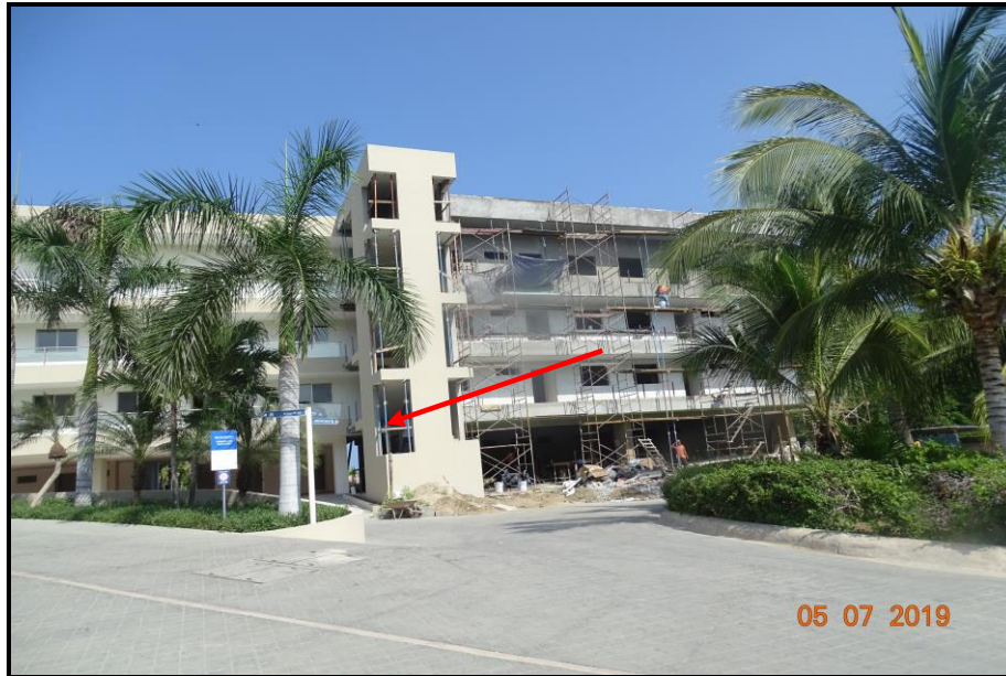
Fotografía 10. El edificio 11-3 colinda en la parte Norte con la vialidad principal de acceso y áreas verdes.
