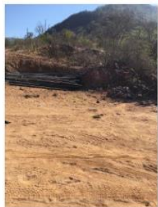
Grupo de fotografías II.34. Almacenamiento de liner
