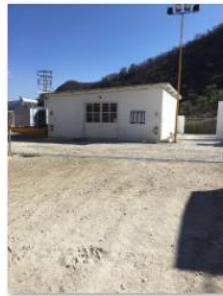
Grupo de fotografías II.25. Subestación eléctrica
