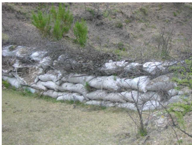
Figura IV. 62 Colocaci3n de costales de material de residuo vegetal a manera de terrazas
