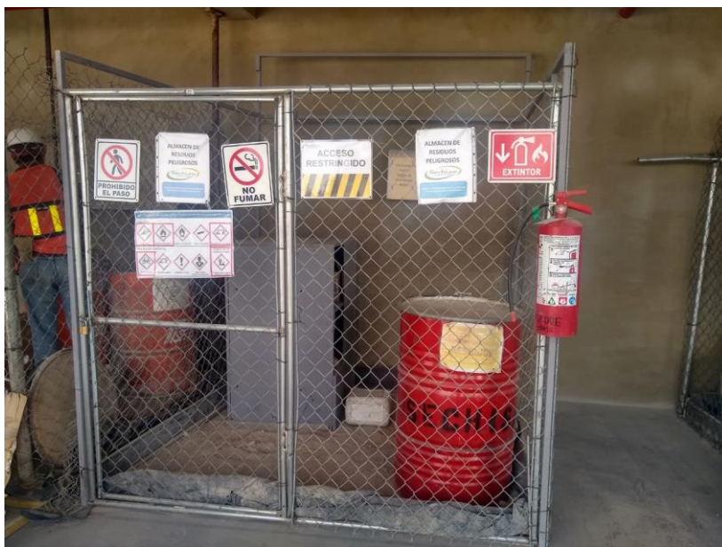
Figura VII. 4 Ejemplo de almacén temporal de Residuos Peligrosos con señalamientos de seguridad
